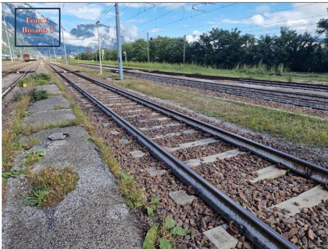
Fig. 1: Vista del binario V (Fonte: RFI).
