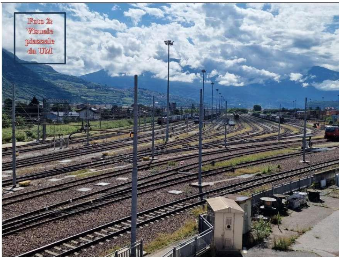
Fig. 2: Una parte del piazzale di stazione vista dall'ufficio Movimento di Trento Roncafort (Fonte: RFI).
