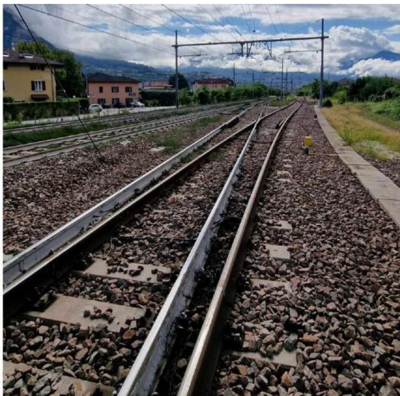
Fig. 7: Comunicazione 06-08, ripresa dalla punta scambio del deviatoio n. 08 (Fonte: RFI).
