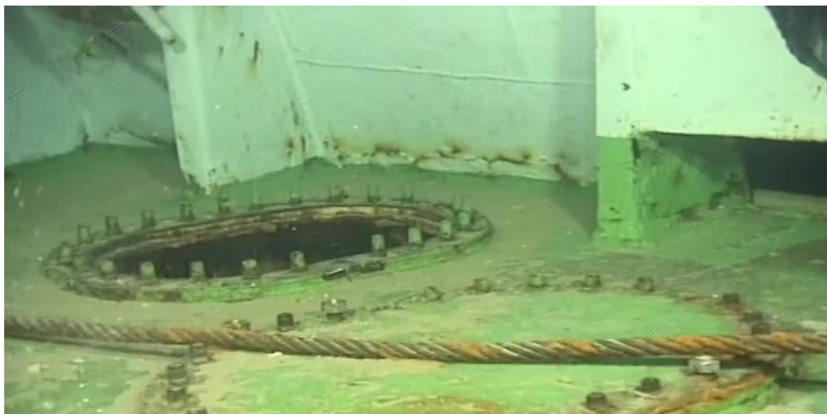
Figura 6 – Poppa del FRANCO P con 2 portelli stagni aperti_ lato sinistro ponte coperta
