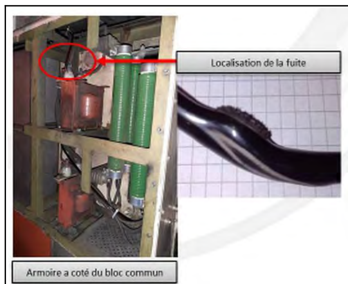
Figura 29: localizzazione della perdita nell'armadio del blocco comune (fonte SNCF Voyageurs TGV)
