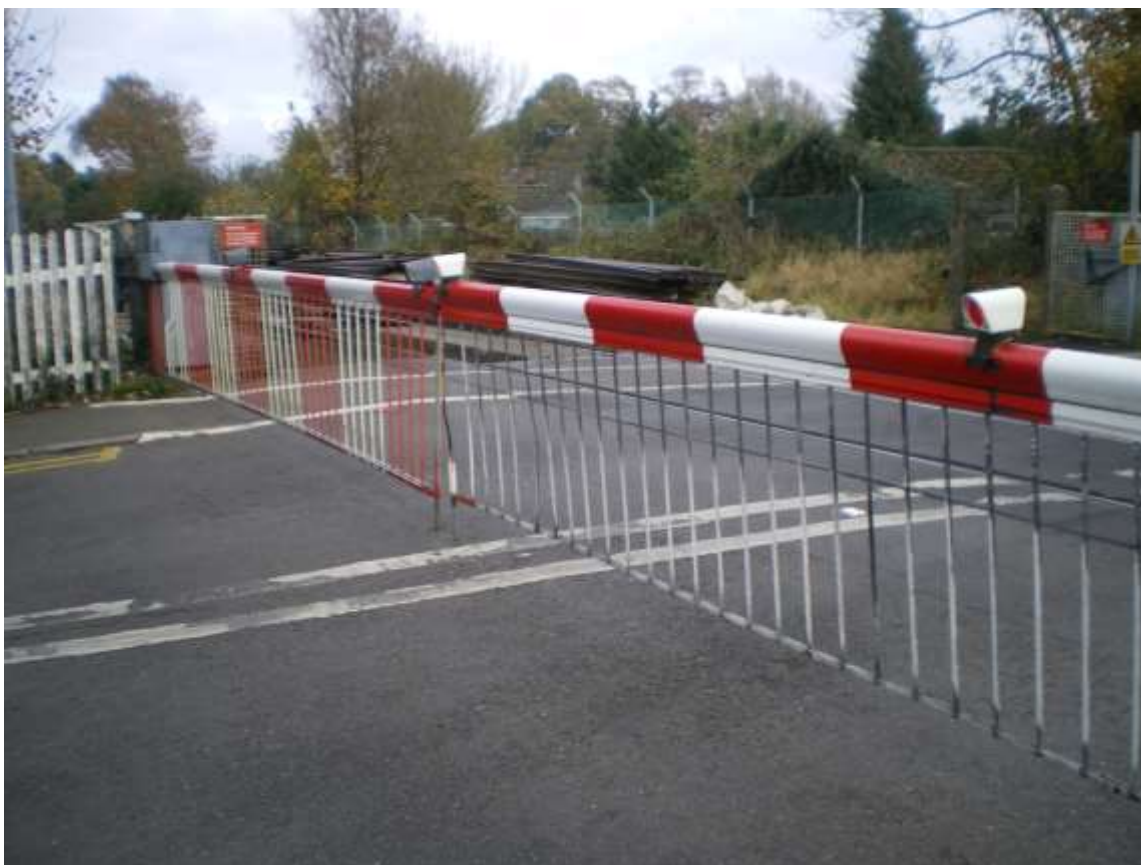
Foto n. 31 - Esempio di PLA con grembiali utilizzato nel Regno Unito.
