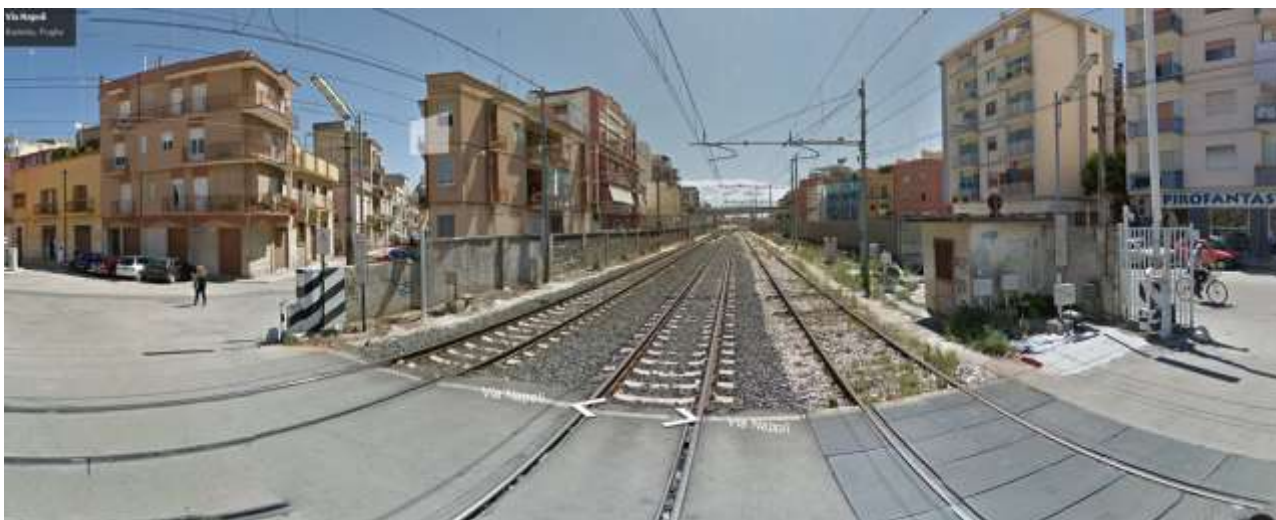
Foto n. 5 - Passaggio a Livello – Via Napoli – Barletta (Google Maps – Street View giugno 2015)
