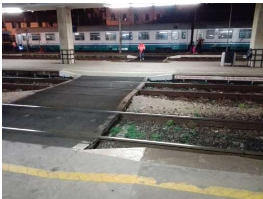
Foto n. 13 - Stazione di La Spezia. Attraversamento a raso posizionato fronte fabbricato viaggiatori (dicembre 2015)
