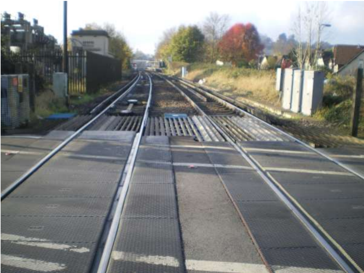
Foto n. 9 – Tipologia di dissuasori di attraversamento binari utilizzati nel Regno Unito (2014)
