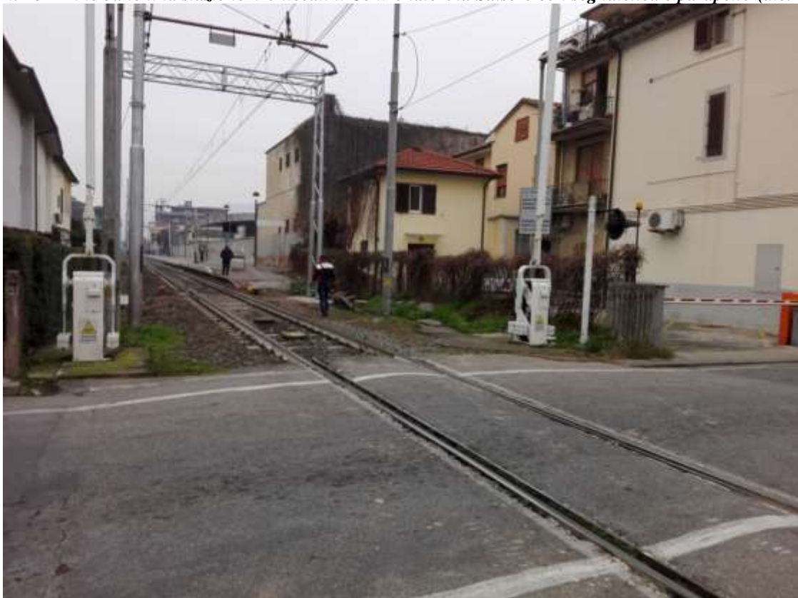
Foto n. 29 – Accesso in banchina attraverso il sentiero che inizia dal PLA in Via Salsero (dicembre 2015)
