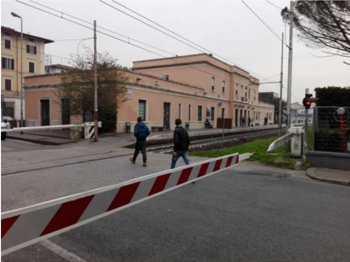
Foto n. 26 - Passaggio a Livello in Via Marruota – Stazione Montecatini Centro (dicembre 2015)
