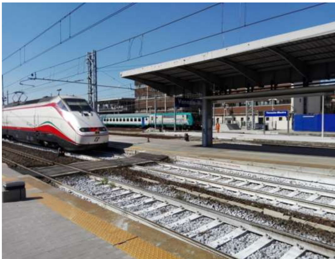
Foto n. 14 - Stazione di Venezia Mestre. Attraversamento a raso realizzato a fine banchina (aprile 2016)
