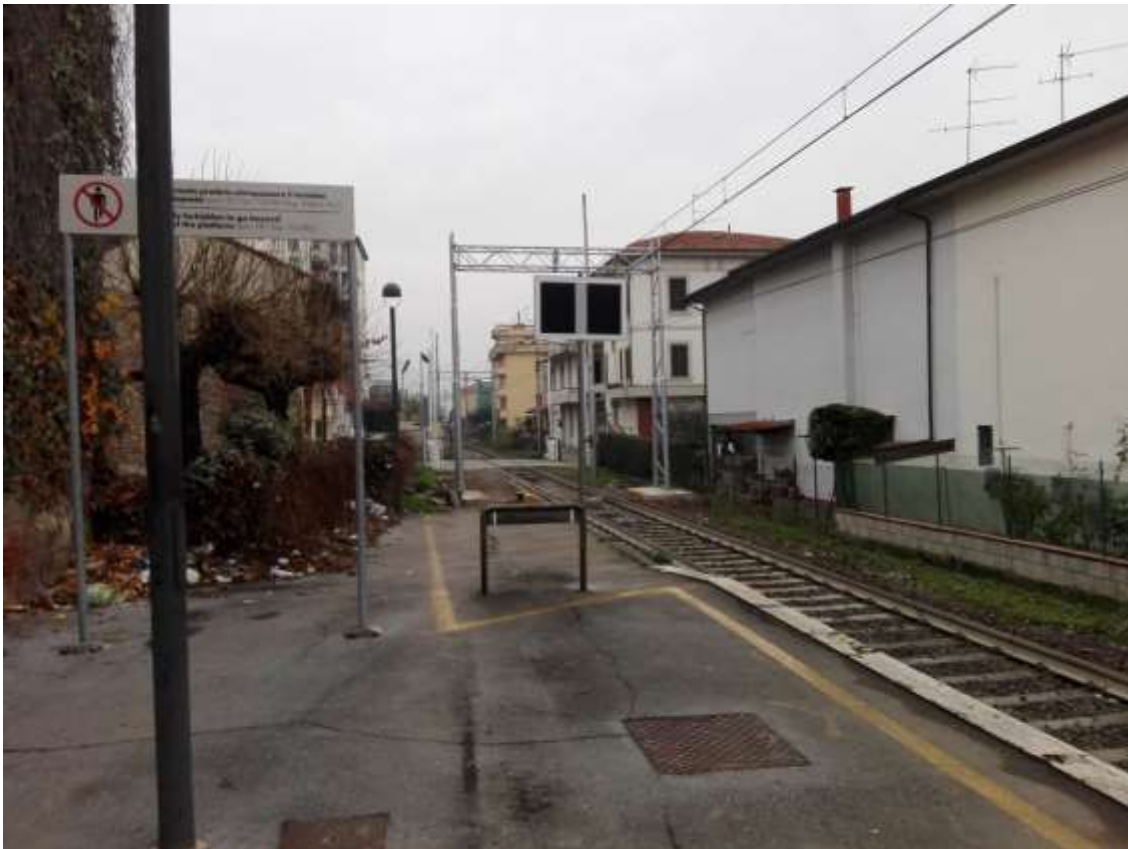
Foto n. 28 – Fine banchina stazione Montecatini Centro lato Via Salsero con segnaletica e parapetto (dic. 2015)
