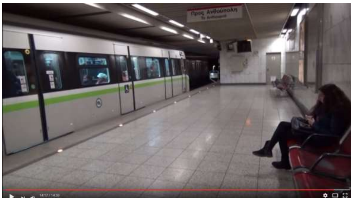
Foto n. 11c - Esempio di delineatori di margine a LED per banchine. Atene - Metro Linea 2 Fotogramma https://www.youtube.com/watch?v=x-MENgYVvcY
