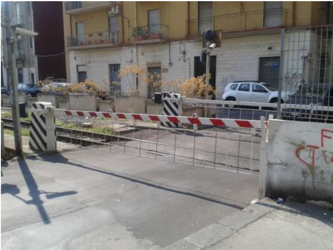
Foto n. 30 - Esempio di PLA con grembiali utilizzato sulla Ferrovia Circumetnea.
