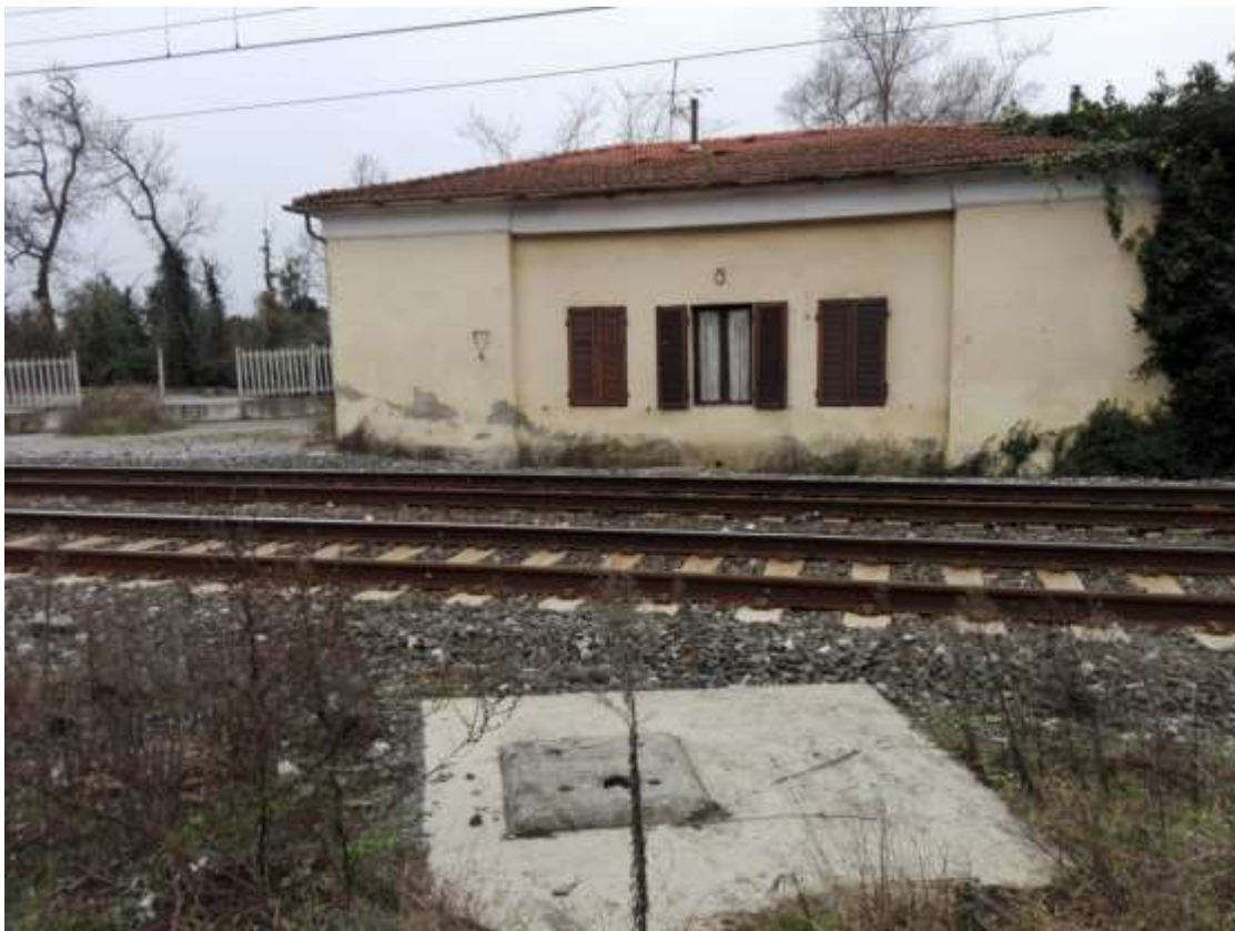
Foto n. 22 – Abitazione adiacente i binari altezza ex Passaggio a Livello Via Vecchianese (dicembre 2015)
