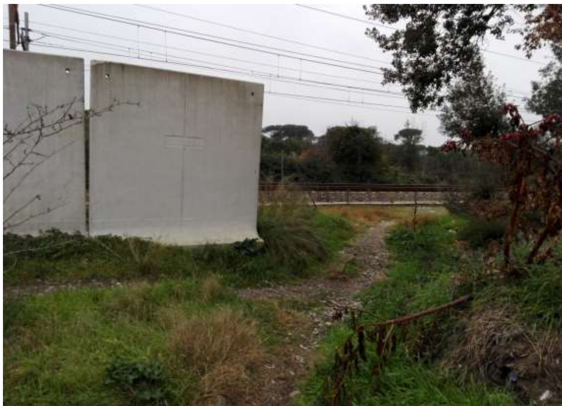
Foto n. 21 –Recinzione in pannelli di cemento in prossimità ex Passaggio a Livello Via Vecchianese (dicembre 2015)
