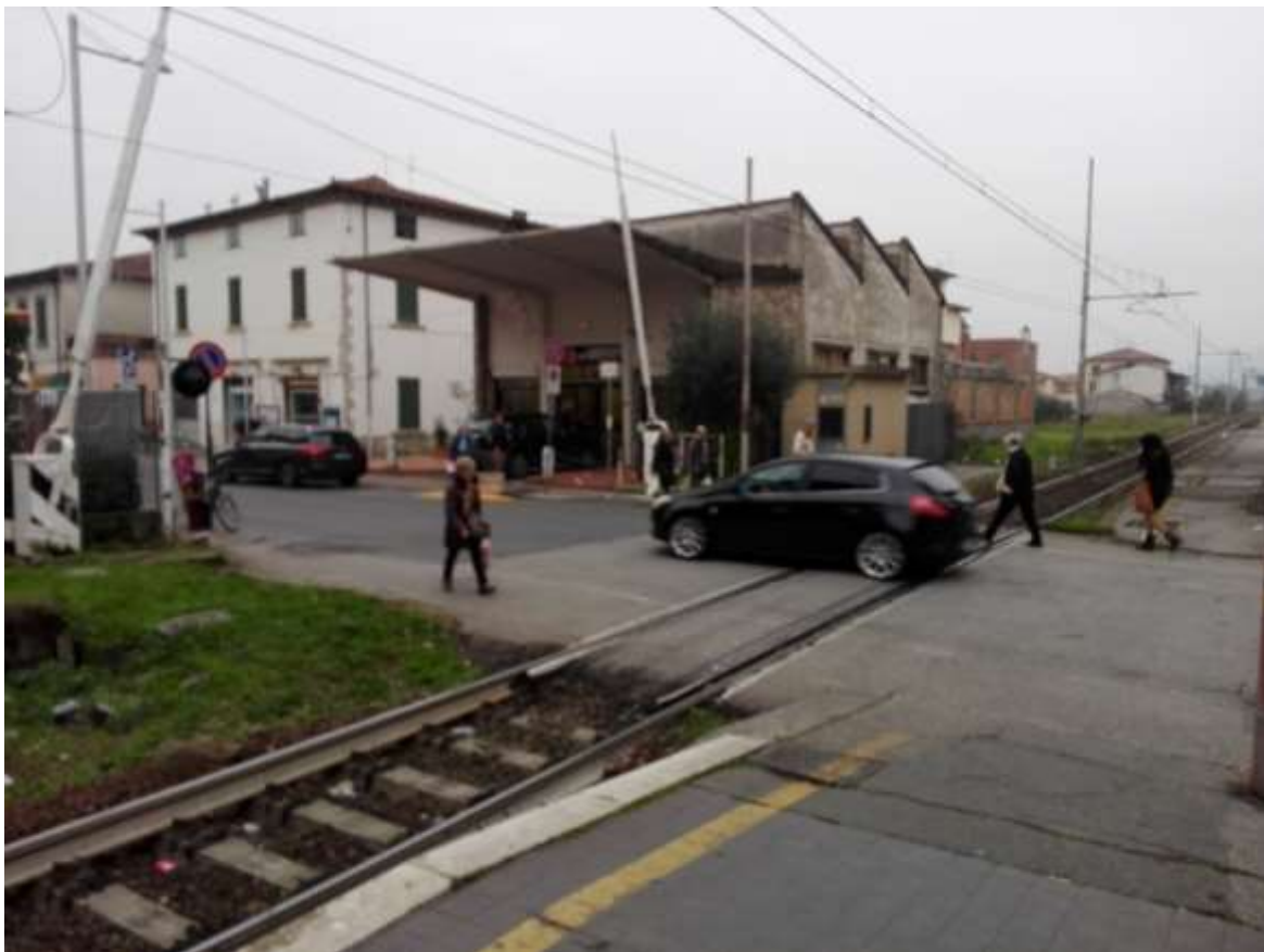
Foto n. 23 - Passaggio a Livello in Via Marruota - Stazione Montecatini Centro (dicembre 2015)
