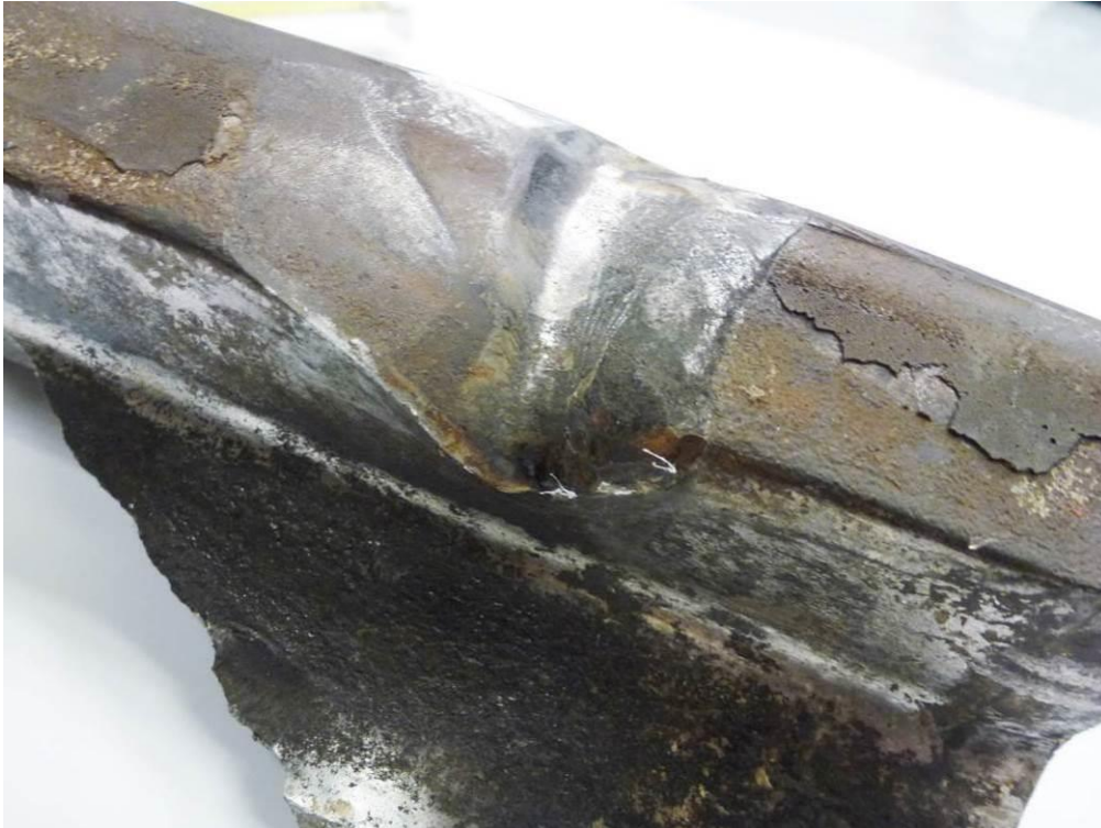
Figura 53 – Vista di un particolare dello spezzone della rotaia del GII distaccata, lato interno del binario. (fonte: Digifema)
