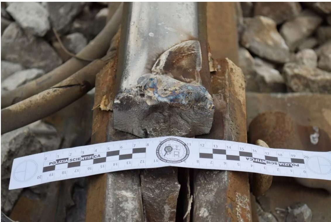
Figura 58 GII km 13+400 in sito, parte fratturata – (fonte: Polizia Scientifica)
