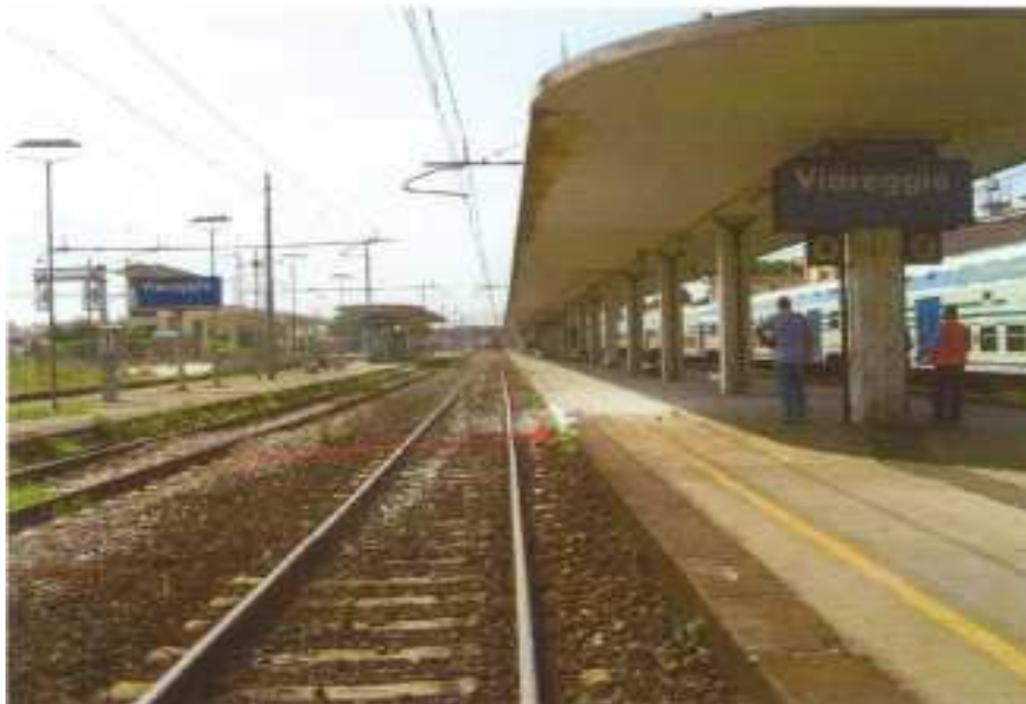
Punto dello svio e conseguente urto sul marciapiede (vista nord – sud) – Fonte Commissione Ministeriale di Indagine
