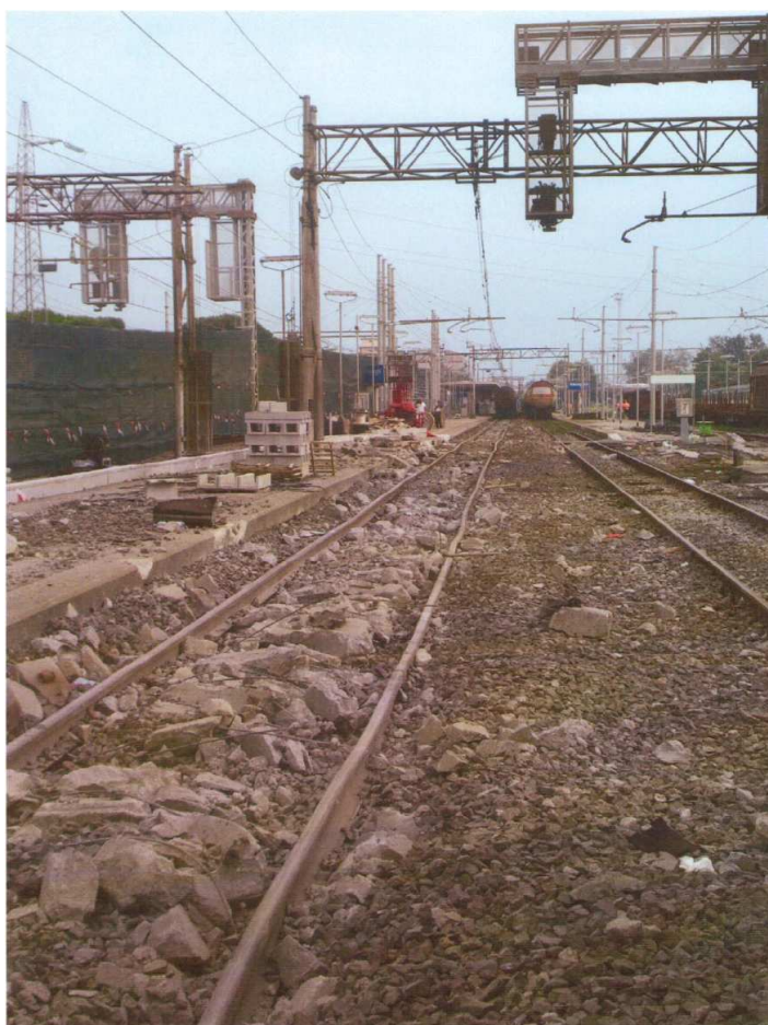
Binario su cui sono deragliati i carri – Fonte Commissione Ministeriale di Indagine
