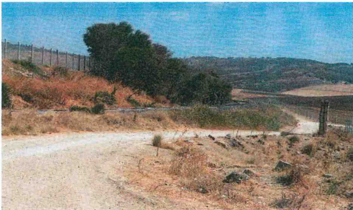
Foto tracciato ferroviario con vista dal basso e dall'alto del terrapieno e della curva. Lato destro delle foto provenienza da Gela del treno 12852
