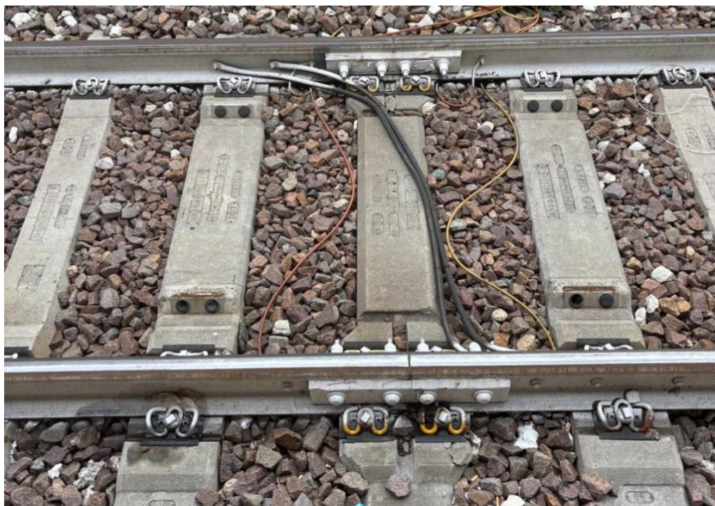
Figura 21 – Esempio di trecce ridondanti (fonte immagine: Commissione di indagine).
