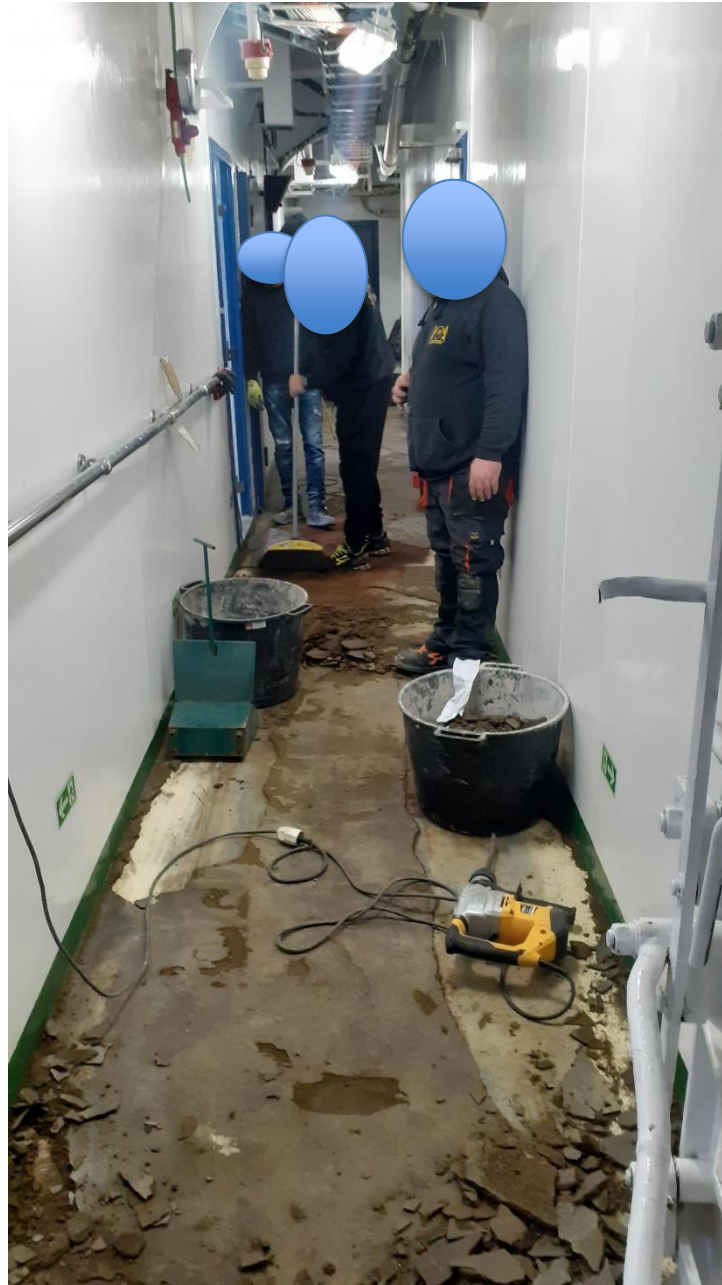
Figura 62 - situazione dei lavori di riparazione del corridoio dello upper under deck il 20/01/2025 – Fonte: fotografia dell'investigatore
