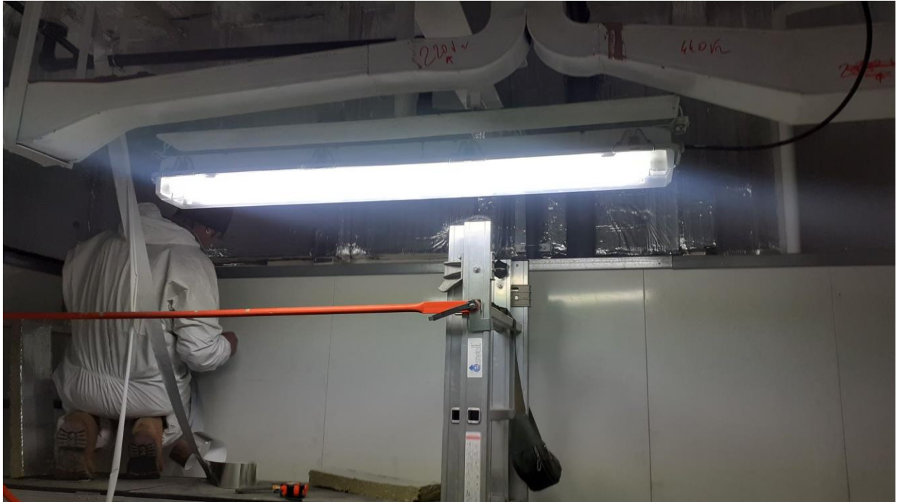
Figura 61 – fase finale dei lavori di riparazione nel locale spogliatoio – Fonte: fotografia dell'investigatore
