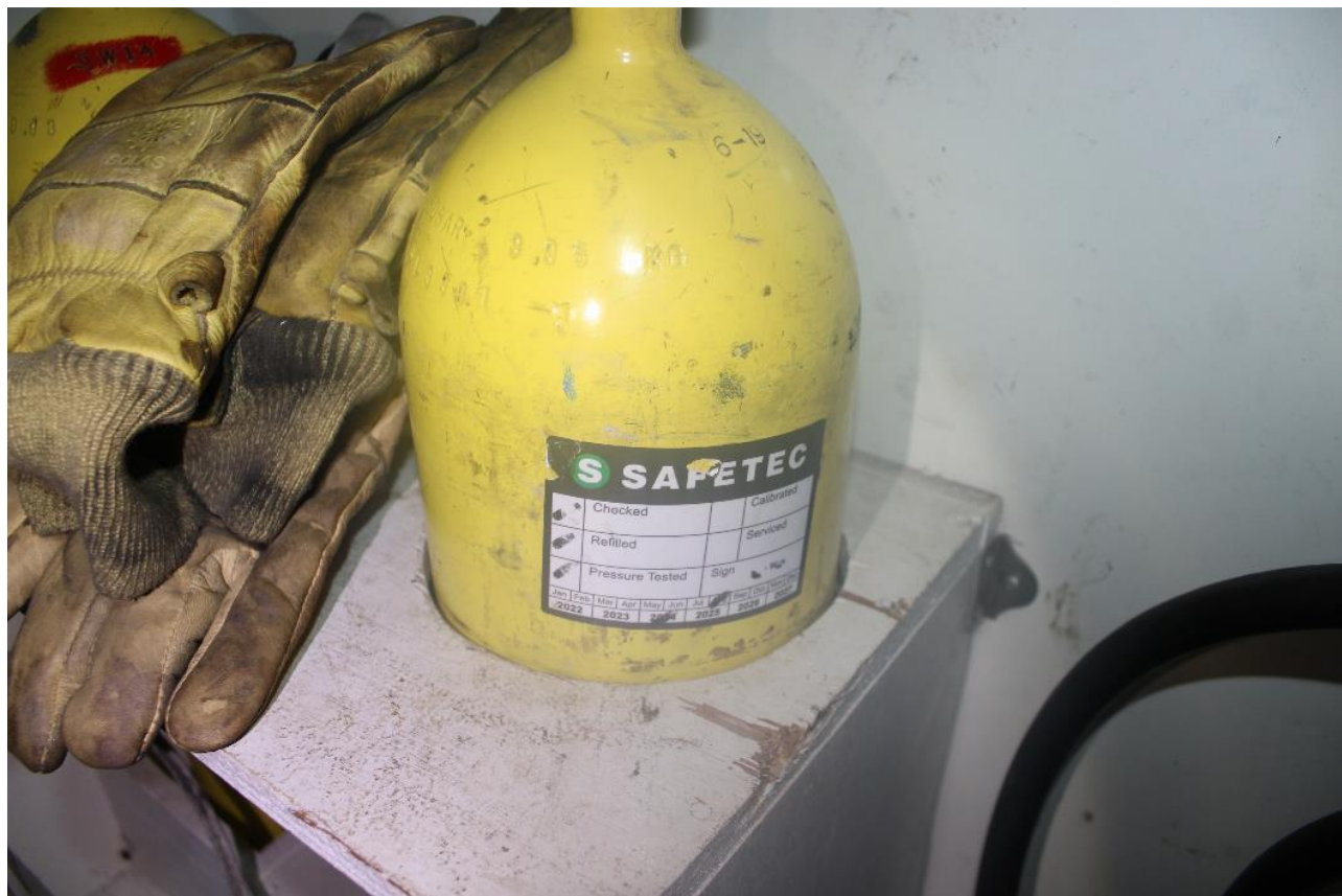
Figura 51 - Targhetta di ispezione datata agosto 2024 su una bombola di autorespiratore nell'armadietto delle attrezzature antincendio sul ponte superiore – Fonte: report BURGOYNES
