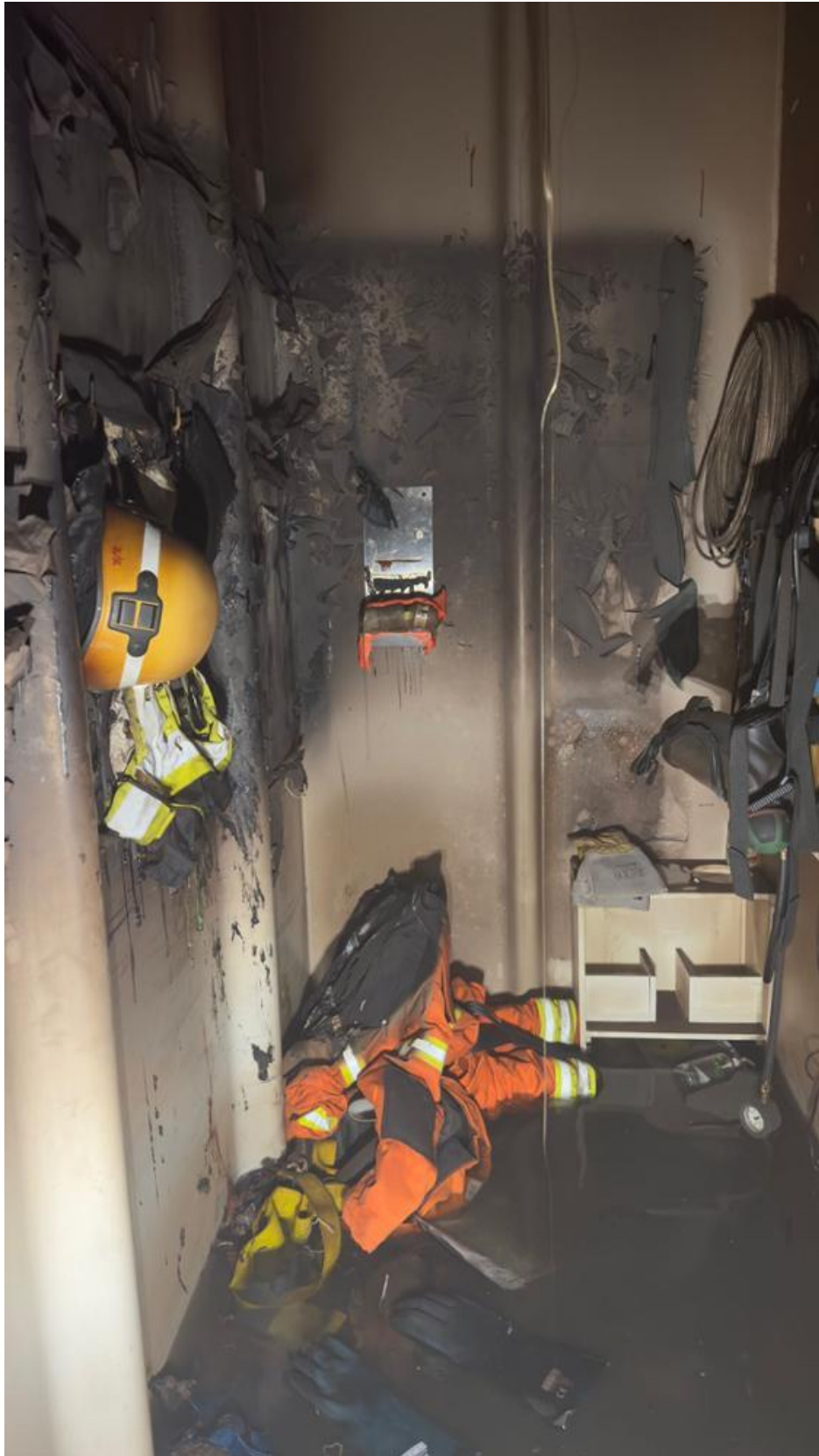
Figura 18 - stipetto dotazioni antincendio n° 1 dopo l'incendio – Fonte: armatore
