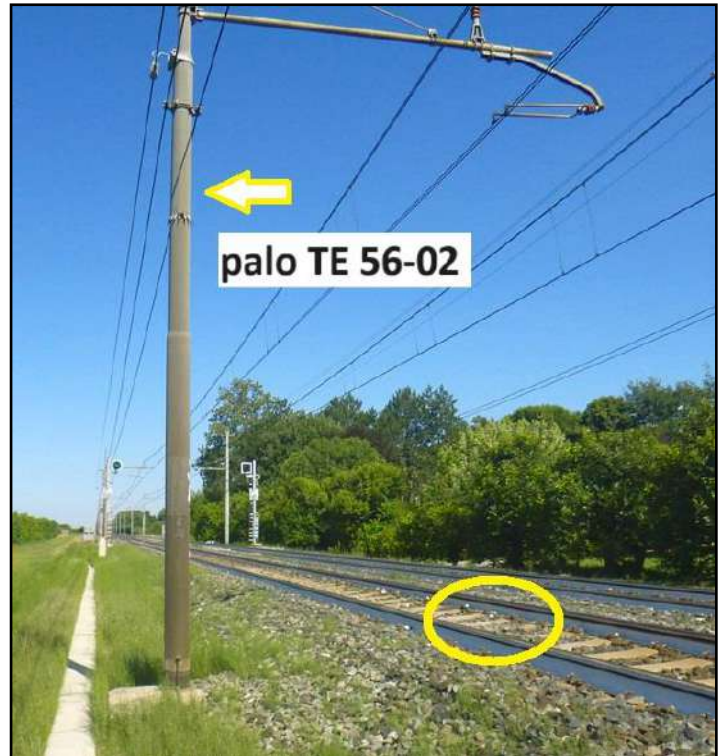
14.6 Palo TE e punto arresto elementi congiunti (fonte Ufficio)
