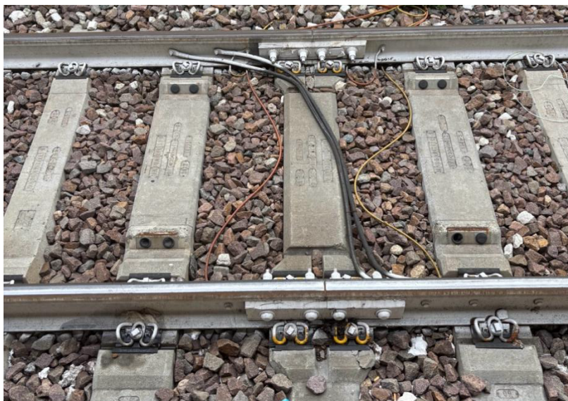
Figura 17 – Esempio di trecce ridondanti (fonte immagine: Commissione di indagine).
