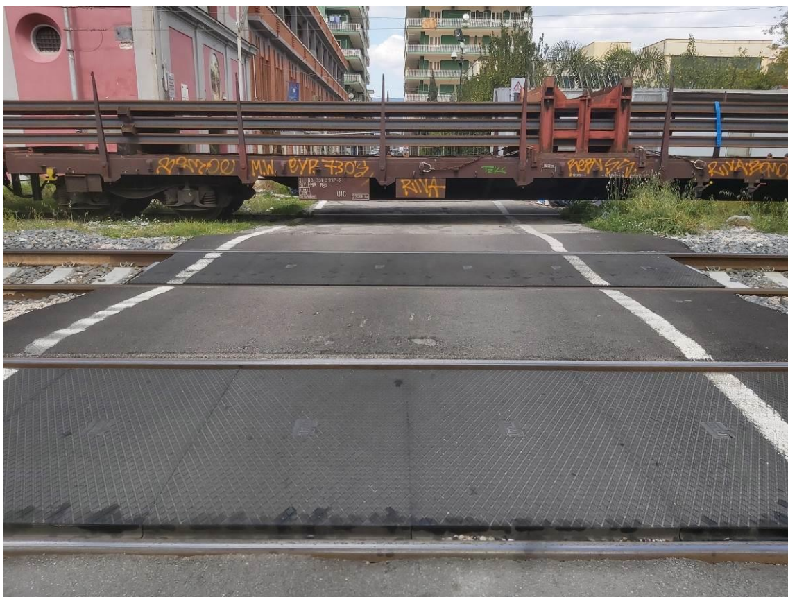
Foto 09: Passaggio a livello km 34+615 con ingombro del convoglio sviato a Pagani (fonte Ufficio)
