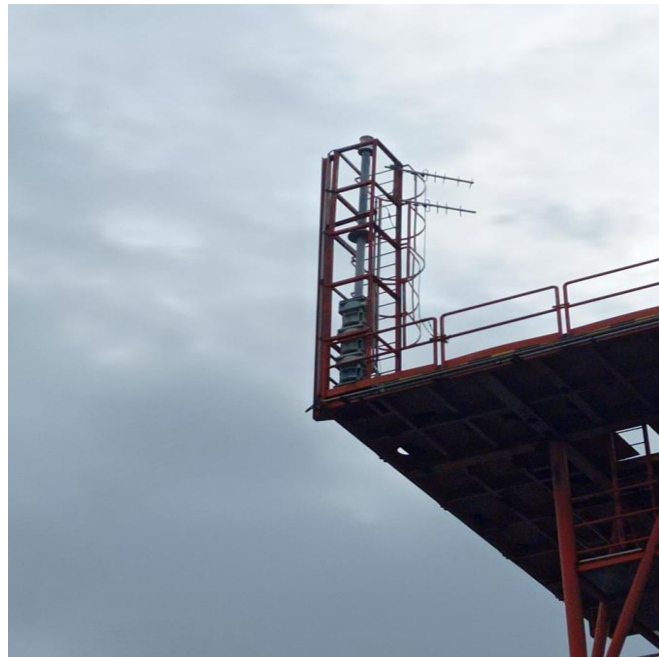
Figura 8 – Foto fanale e nautofono piattaforma “FABRIZIA”
