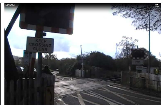
Figura 117: ubicazione dei 4 telefoni di emergenza posti in corrispondenza del PL impresenziato di Milford nel Regno Unito
