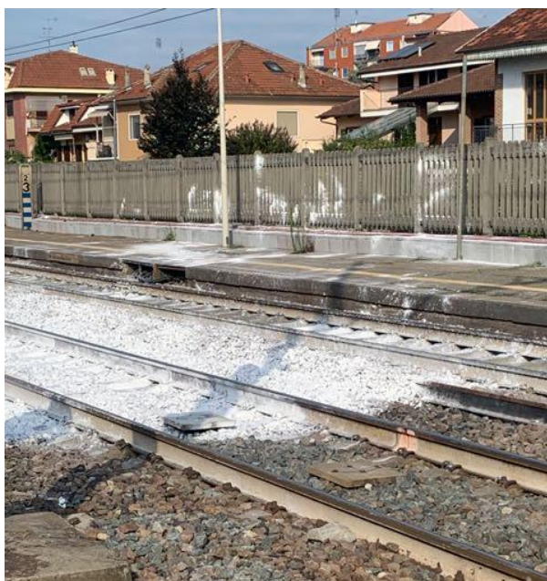
Fig. 15 e 16 – Vista zona cantiere e difetto (Fenditura Orizzontale all'estremità di rotaia) marcato con vernice rossa (pr. km 23+086) definito erroneamente "232".
