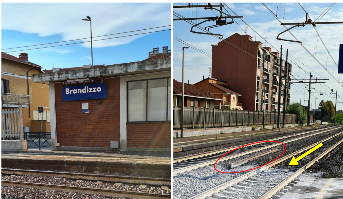
Fig. 1 e 2 – Fabbricato viaggiatori della stazione di Brandizzo (TO) e Area di cantiere: cerchiato in rosso lo spezzone di rotaia da inserire in sostituzione a quello in loco; la freccia in giallo indica la provenienza e il verso di percorrenza del treno.
