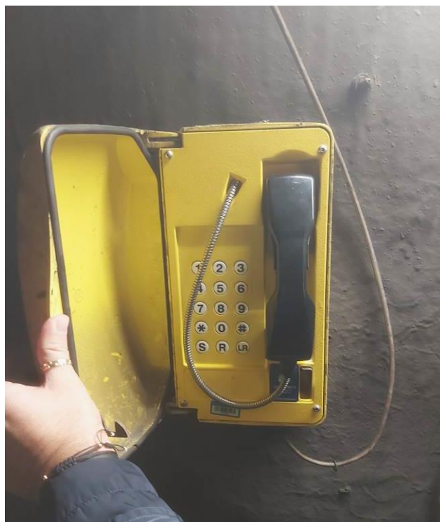
Foto 09: Telefono fisso, di tipo "selettivo", in prossimità del segnale di protezione di Pozzano (fonte Ufficio)
