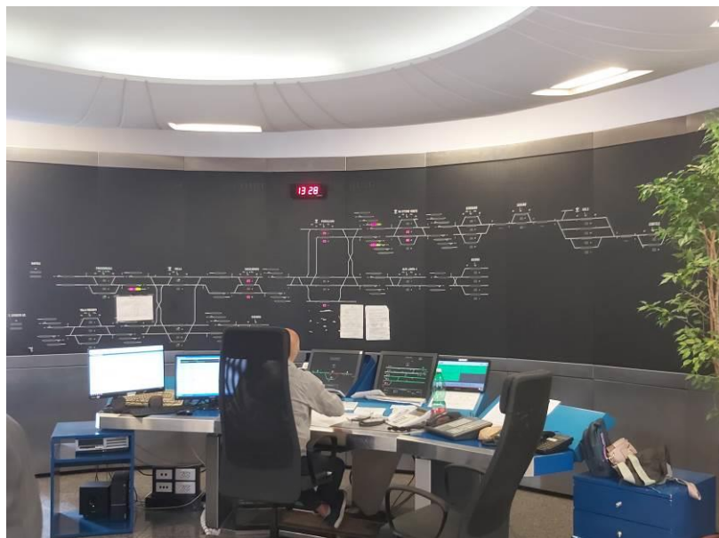
Foto 05 e 06: Ingresso sala DCO di EAV - Postazione e quadro luminoso della DU3 (fonte Ufficio)
