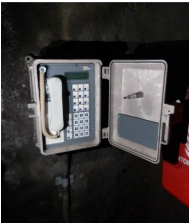
Foto 09: Telefono fisso, di tipo "selettivo", in prossimità del segnale di protezione di Pozzano (fonte Ufficio)
