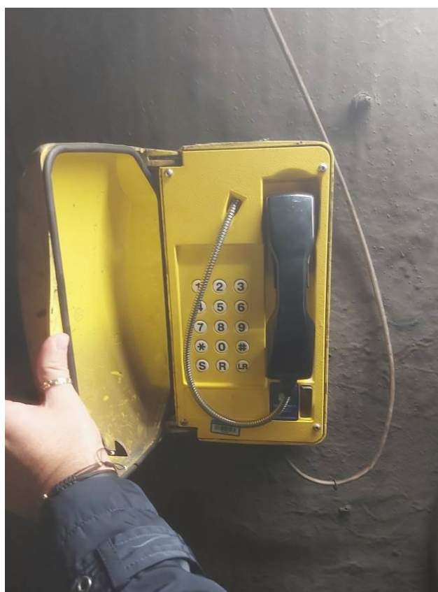
Foto 09: Telefono fisso, di tipo "selettivo", in prossimità del segnale di protezione di Pozzano (fonte DIGIFEMA)
