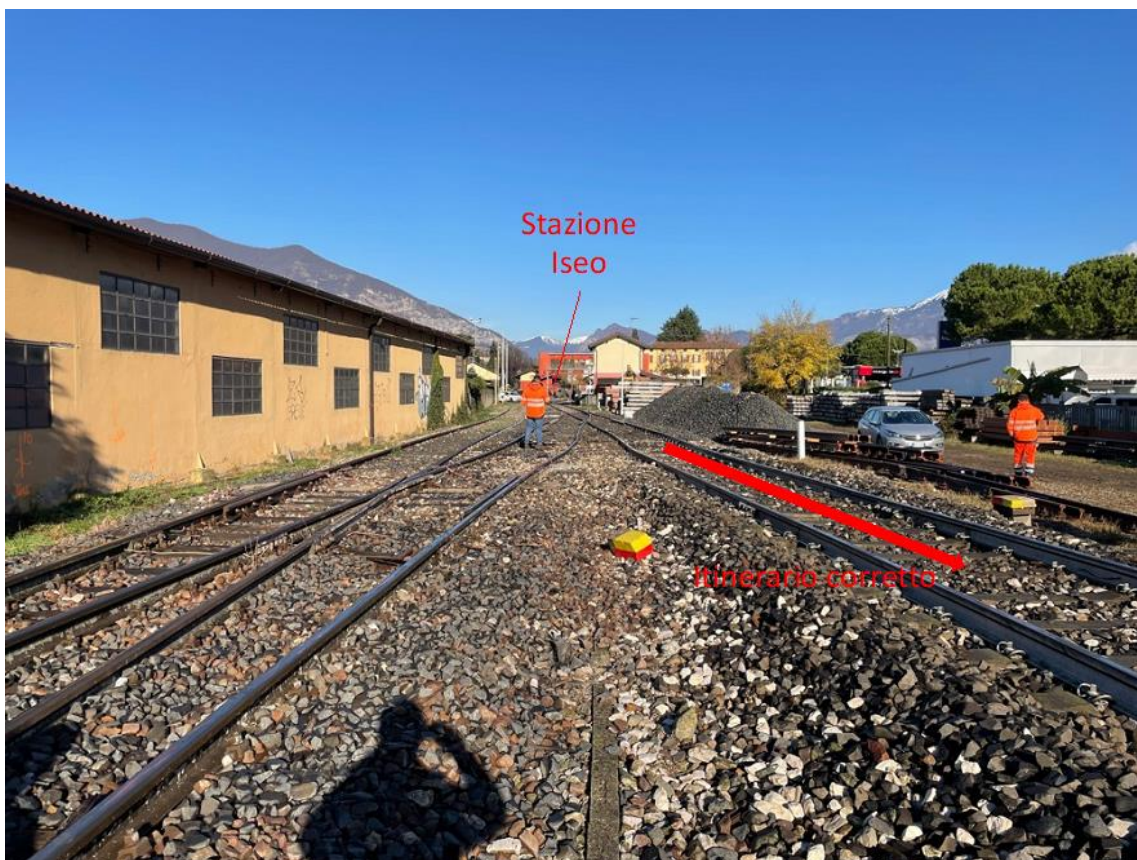
Figura 8 – Localizzazione della zona dove si è fermato il treno dopo lo svio (fonte immagine: DiGIFeMa; elaborazione: DiGIFeMa)
