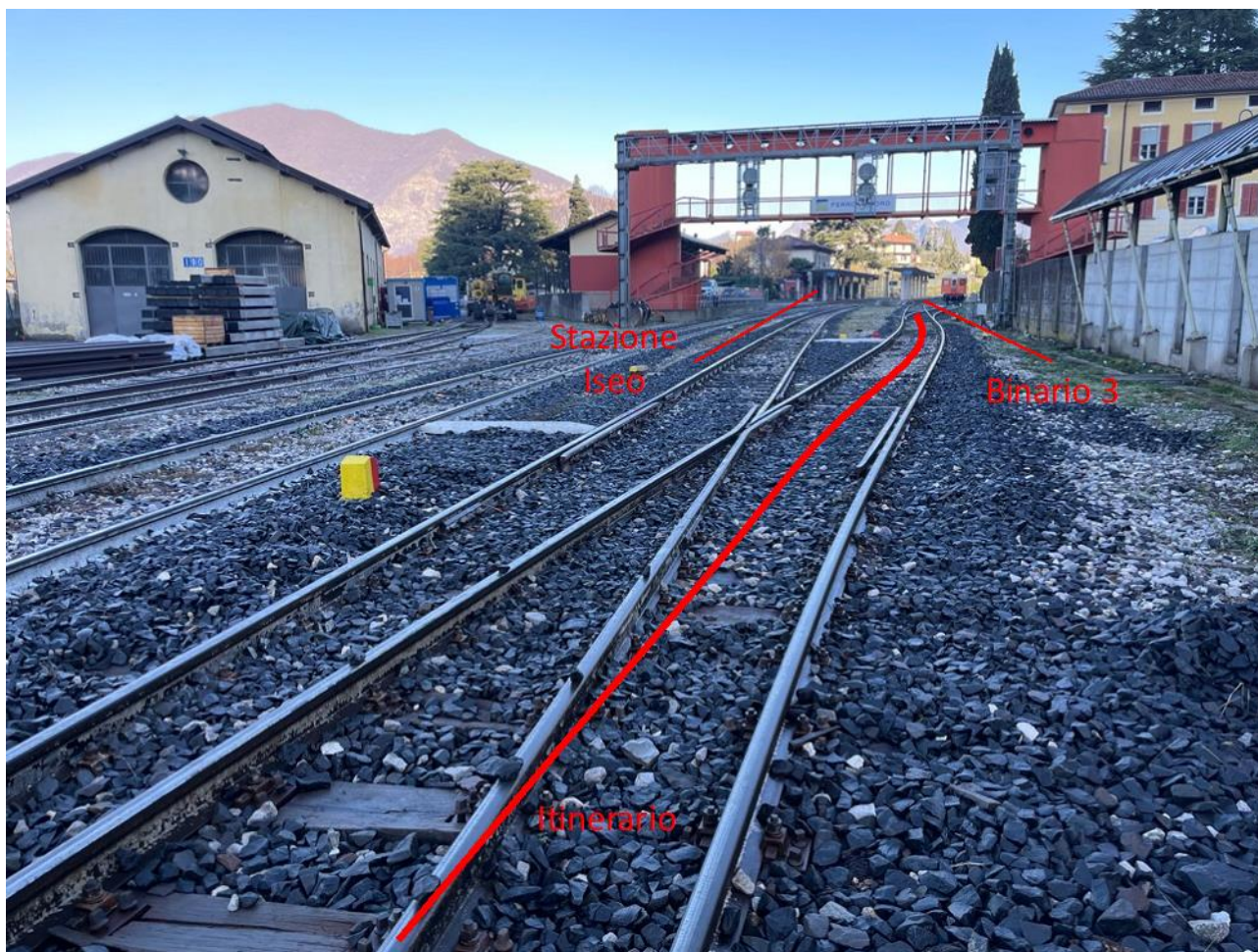
Figura 6 – Scenario dell'evento in prossimità della stazione di Iseo (fonte immagine: DiGIFeMa; elaborazione: DiGIFeMa)
