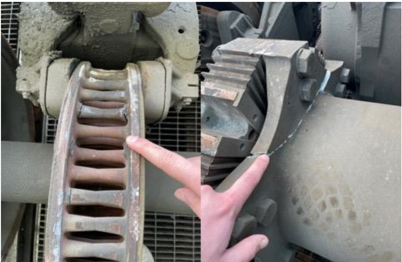
Figura 16 – Dettaglio danni al carrello (fonte immagine: DiGIFeMa)
