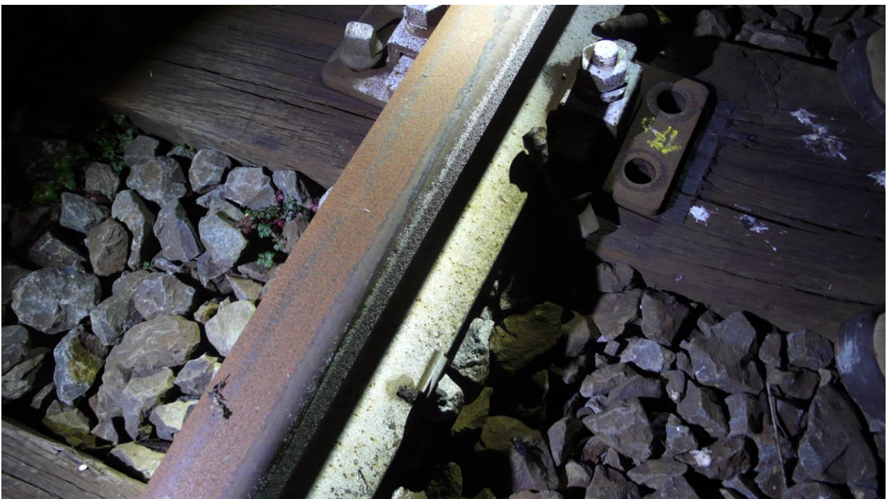
Foto 09 e 10: Sopralluogo del 20/02/2023 – (fonte DiGIFeMa)
