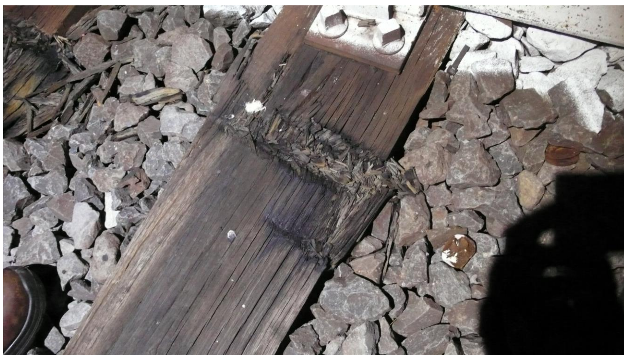
Foto 11 e 12: Sopralluogo del 20/02/2023 (fonte DiGIFeMa)
