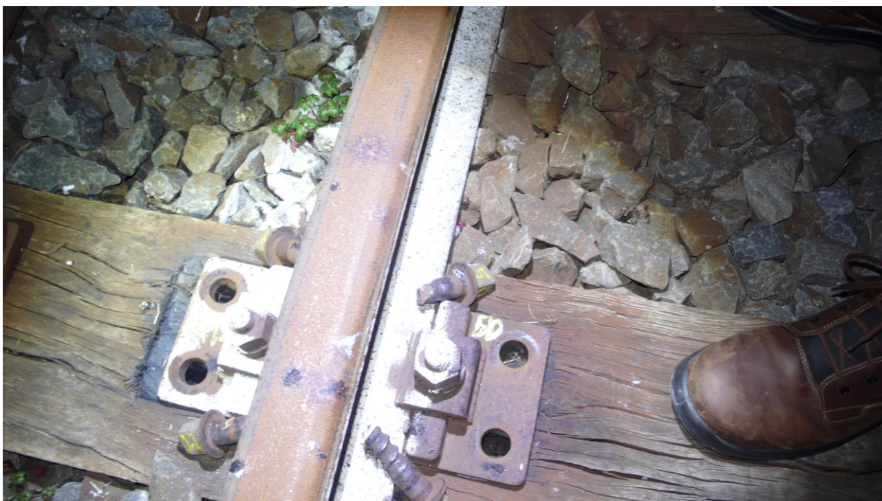
Foto 07 e 08: Sopralluogo del 20/02/2023 (fonte DiGIFeMa)
