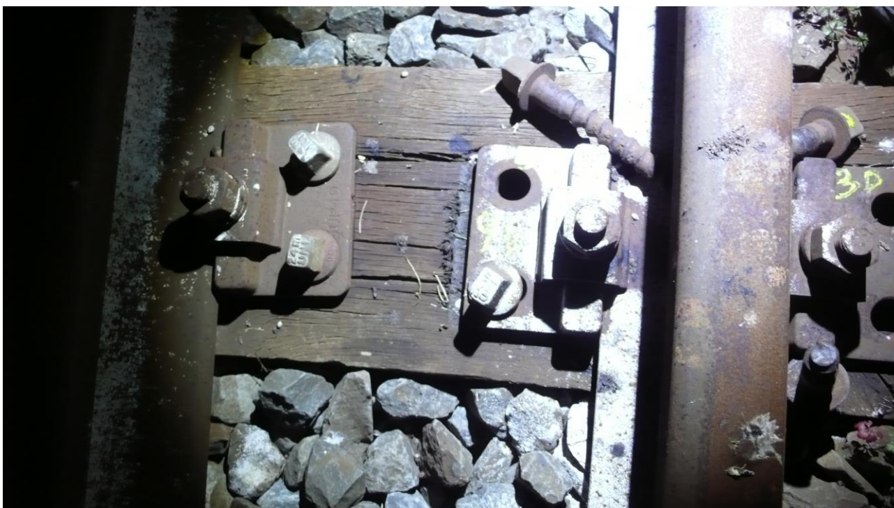
Foto 05 e 06: Sopralluogo del 20/02/2023 (fonte DiGIFeMa)
