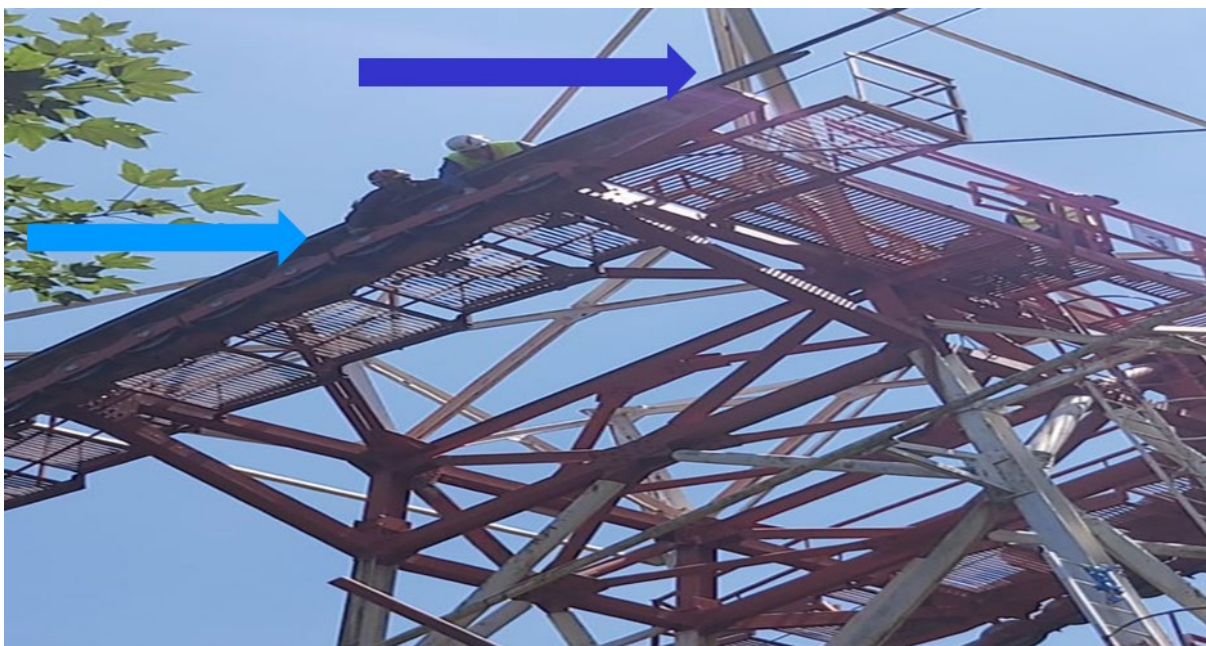
Foto 3 - Sostegno n.3: carrelliera (freccia blu) e scarpa della fune portante (freccia azzurra) lato veicolo n.4 (Fonte DiGIFeMa).
