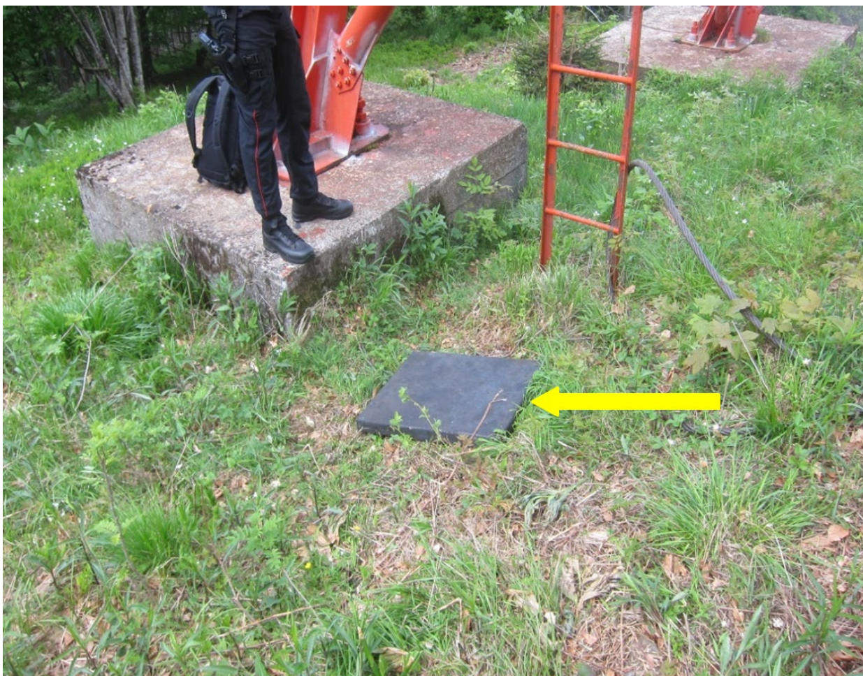
Foto 2 - Una botola della cabina 3 (freccia gialla) rinvenuta presso il basamento verso monte del sostegno n.3 (Fonte DiGIFeMa).
