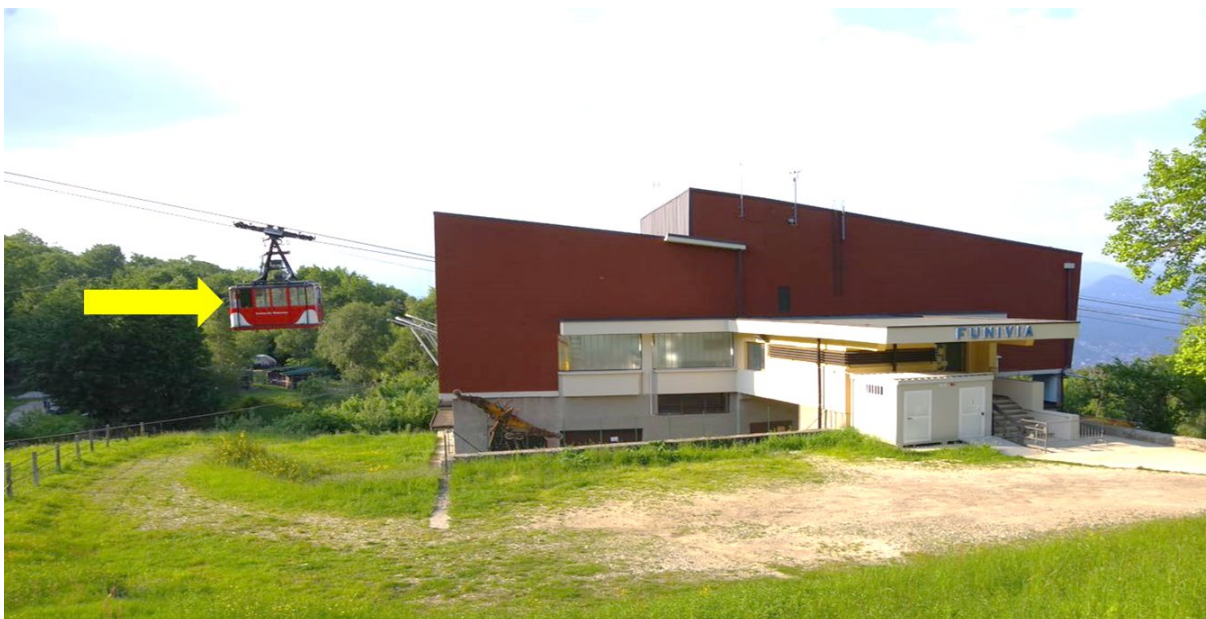
Foto 24 - Stazione Motrice di Alpino con cabina n.4 ferma a 14 mt dalla fossa per intervento del freno automatico sulla portante (fonte DiGIFeMa).
