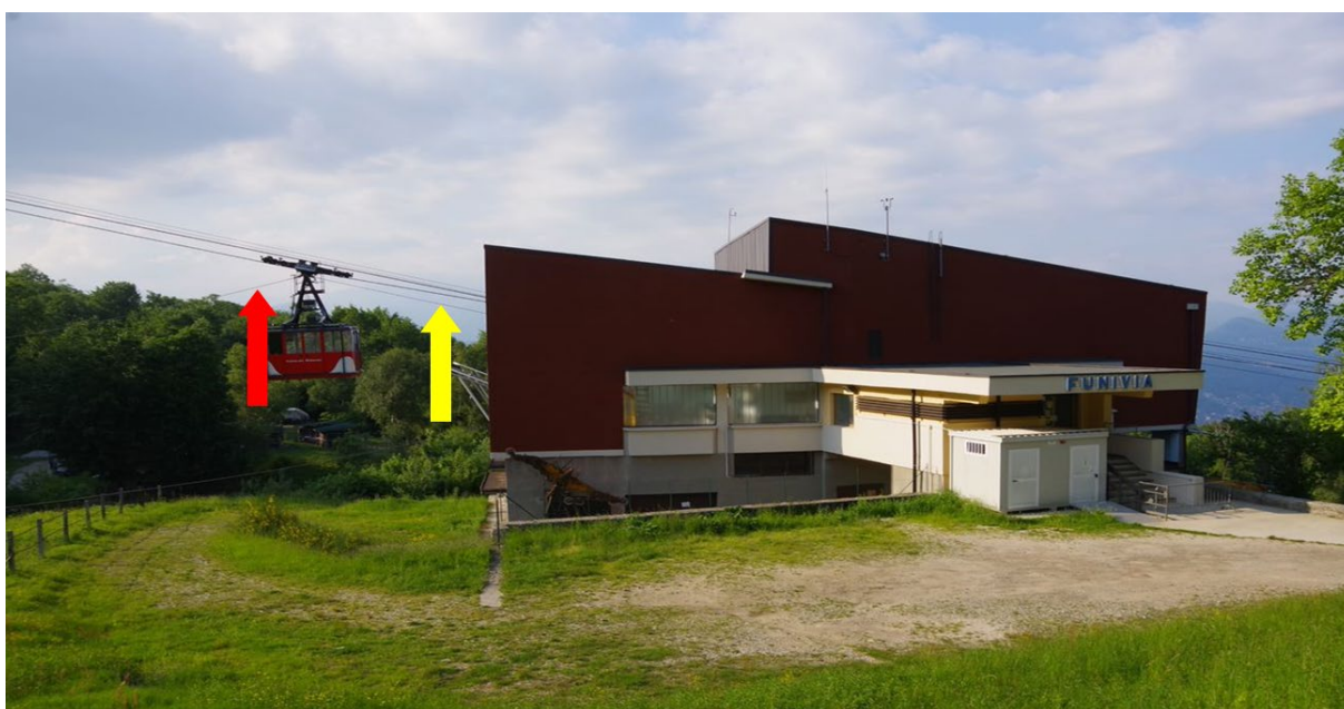
Foto 14 - Cabina n.4 ferma a circa 14 m dall'ingresso della fossa per l'intervento automatico del freno sulla portante per rottura della fune traente superiore appoggiata al suolo (freccia rossa) e traente inferiore (freccia gialla) (Fonte DiGIFeMa).
