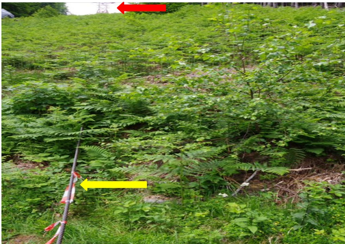
Foto 13 - Fune Traente inferiore (freccia gialla) collegata da una parte alla testa fusa del carrello della cabina 4 incastrata contro un albero, appoggiata al suolo tra il sostegno 3 (freccia rossa) e il declivio sotteso alla campata lunga, e dall'altra parte passante sulla rulliera del sostegno 2 (Fonte DiGIFeMa).
