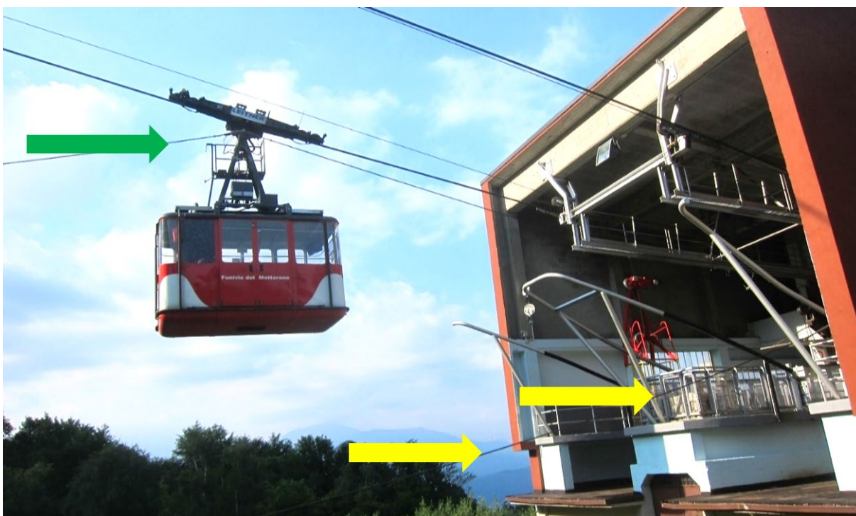
Foto 25 - Stazione Motrice di Alpino con la cabina n.4 ferma per l'intervento del freno automatico sulla portante. Si nota la fune traente superiore inclinata verso terra (freccia verde) e la traente inferiore (freccie gialle) che dopo il giro di puleggia si appoggia sul terreno e sul sostegno 1 (non visibile). Entrambi i semianelli sono privi di tensione (fonte DiGIFeMa).
