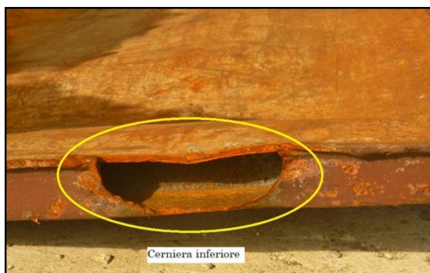
15f. Particolare posizione cerniera inferiore (fonte DiGIFeMa)
