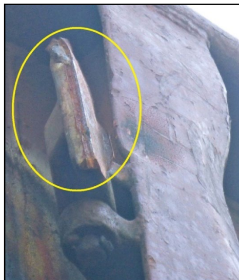
13f. Cerniera superiore divelta (fonte DiGIFeMa)
