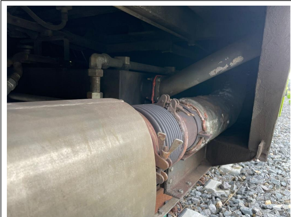
Figura 18 – Vano tubo di scarico con particolare del tubo di rifornimento (fonte: DiGIFeMa)
