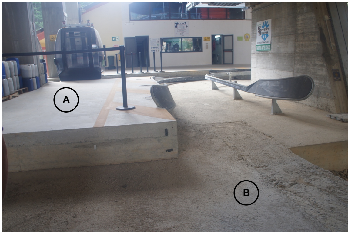
Figura 4 - Particolare delle zone A e B della stazione di arrivo (fonte ed elaborazione DiGIFeMa)
