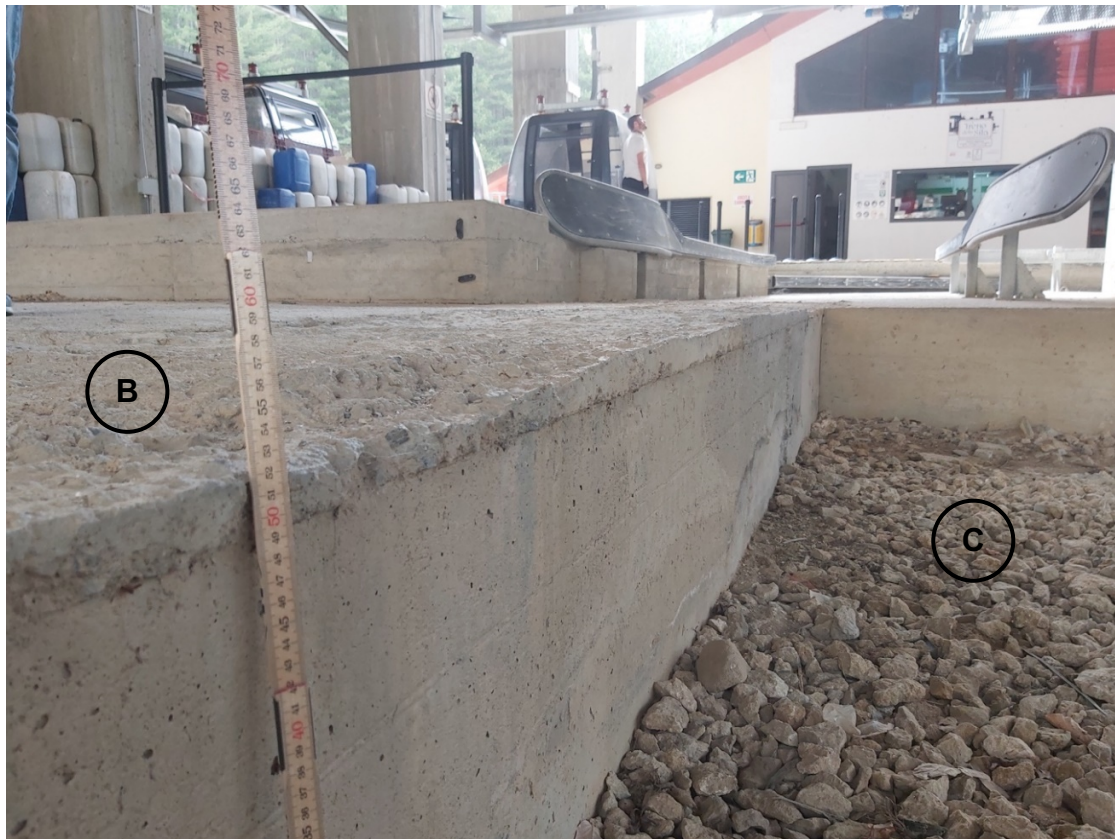
Figura 6 – Differenza di quota fra le zone B e C (fonte ed elaborazione DiGIFeMa)
