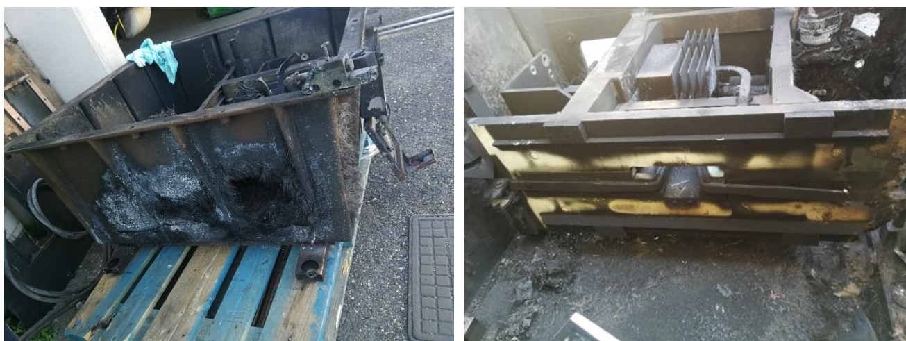
13. JR coinvolto nell'evento del 09.12.2021 dopo lo smontaggio (Fonte DiGIFeMa)
