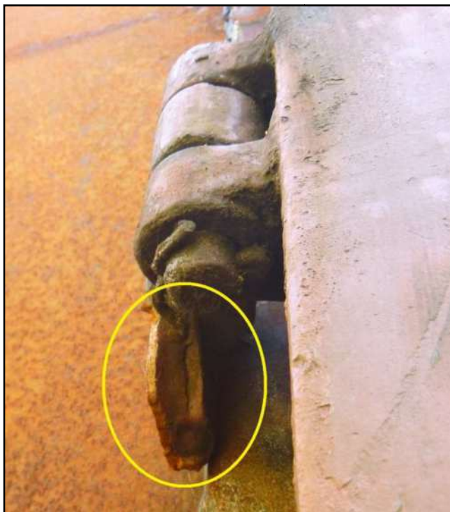
18/e. Cerniera inferiore divelta (fonte DiGIFeMa)
