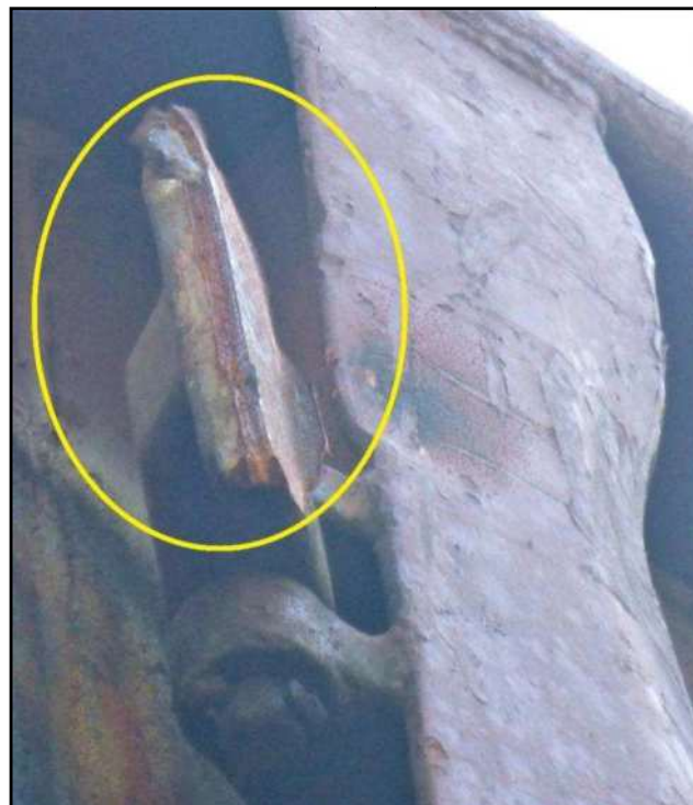
18/f. Cerniera superiore divelta (fonte DiGIFeMa)
