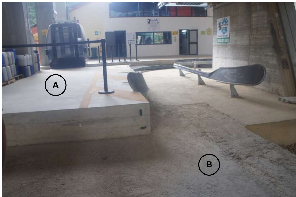
Figura 4 - Particolare delle zone A e B della stazione di arrivo.
