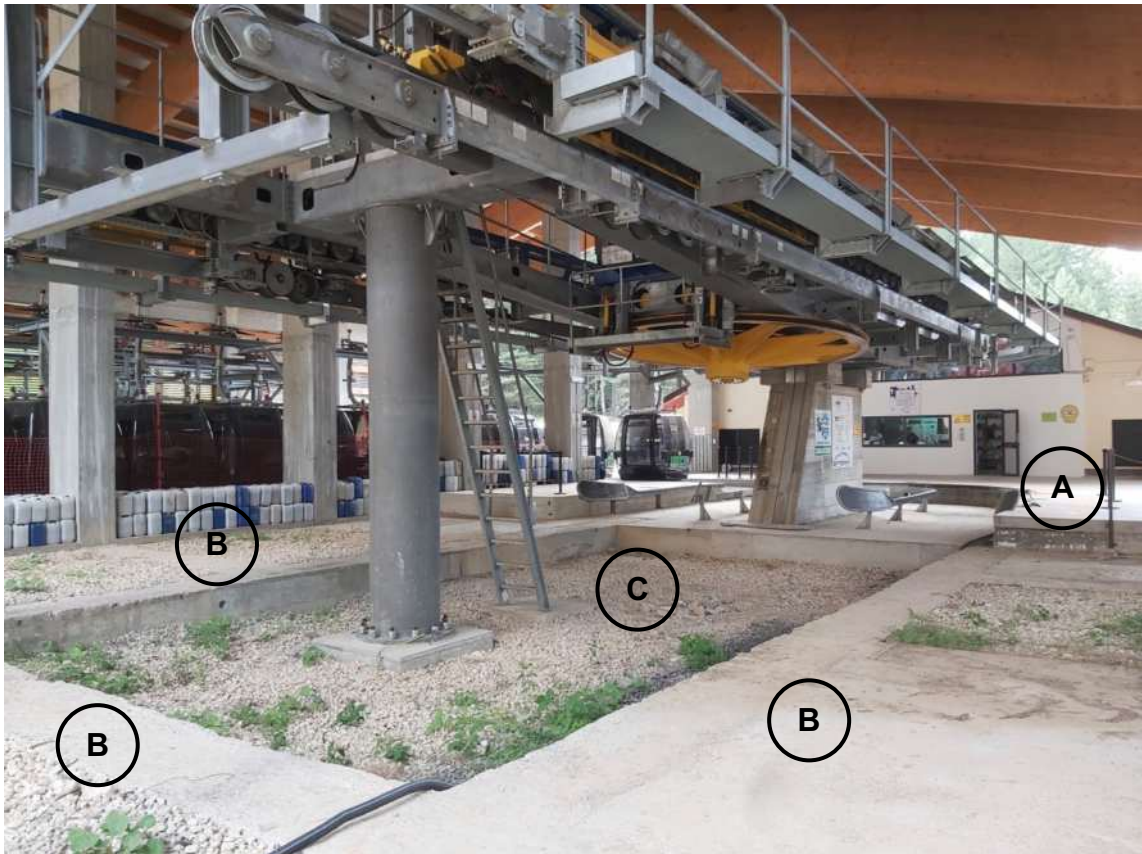
Figura 3 - Vista d'insieme della stazione di arrivo con indicazione delle diverse zone
