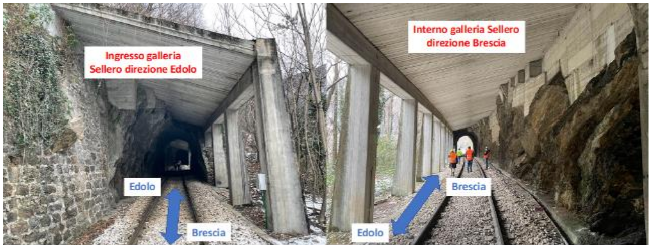
Figura 8 – Ingresso e interno della galleria Sello interessata dall’evento. L’ingresso lato Brescia in direzione Edolo è caratterizzato dalla presenza di una galleria paramassi (fonte: Commissione d’indagine - sopralluogo del 10/12/2021).
