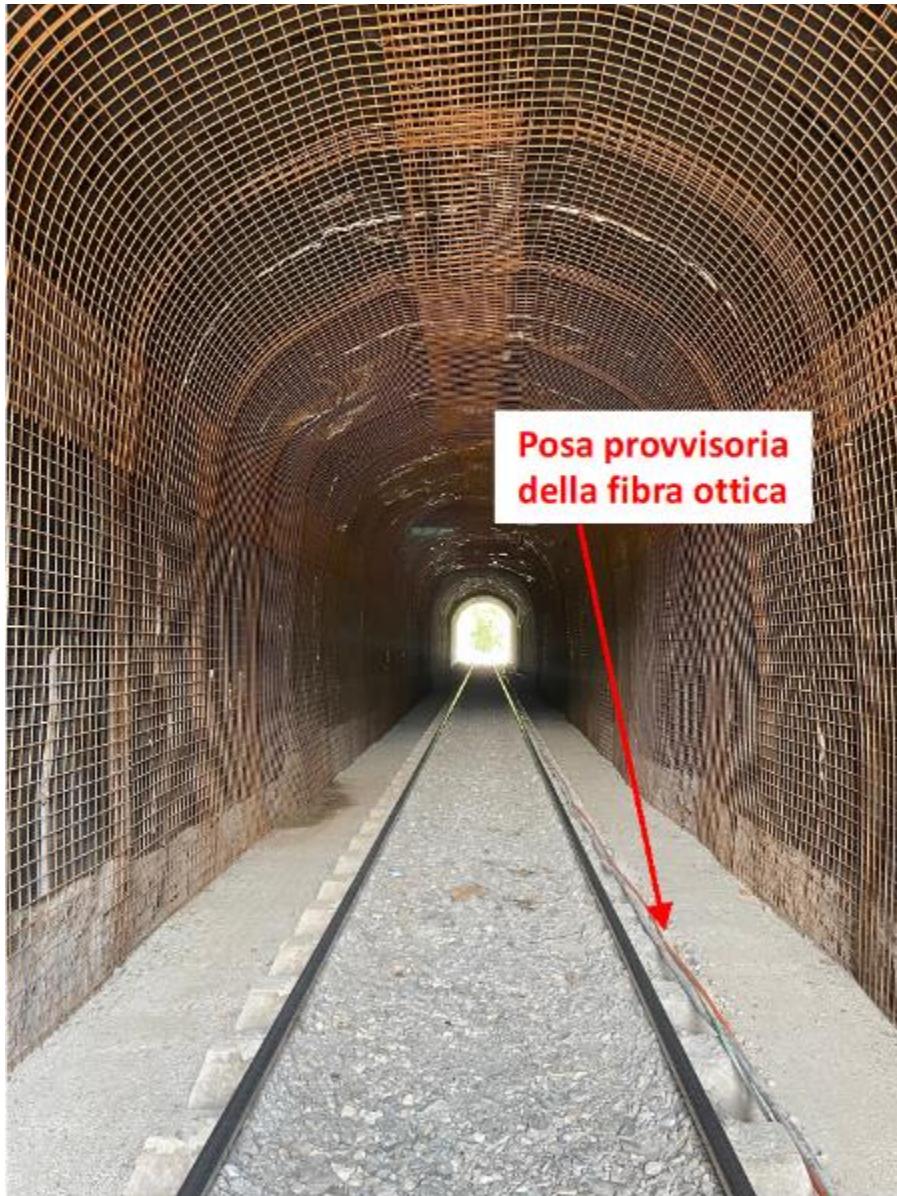
Figura 12 – Posa provvisoria del sistema di monitoraggio in fibra ottica all'interno della galleria (fonte: Commissione d'indagine - sopralluogo del 01/06/2022).
