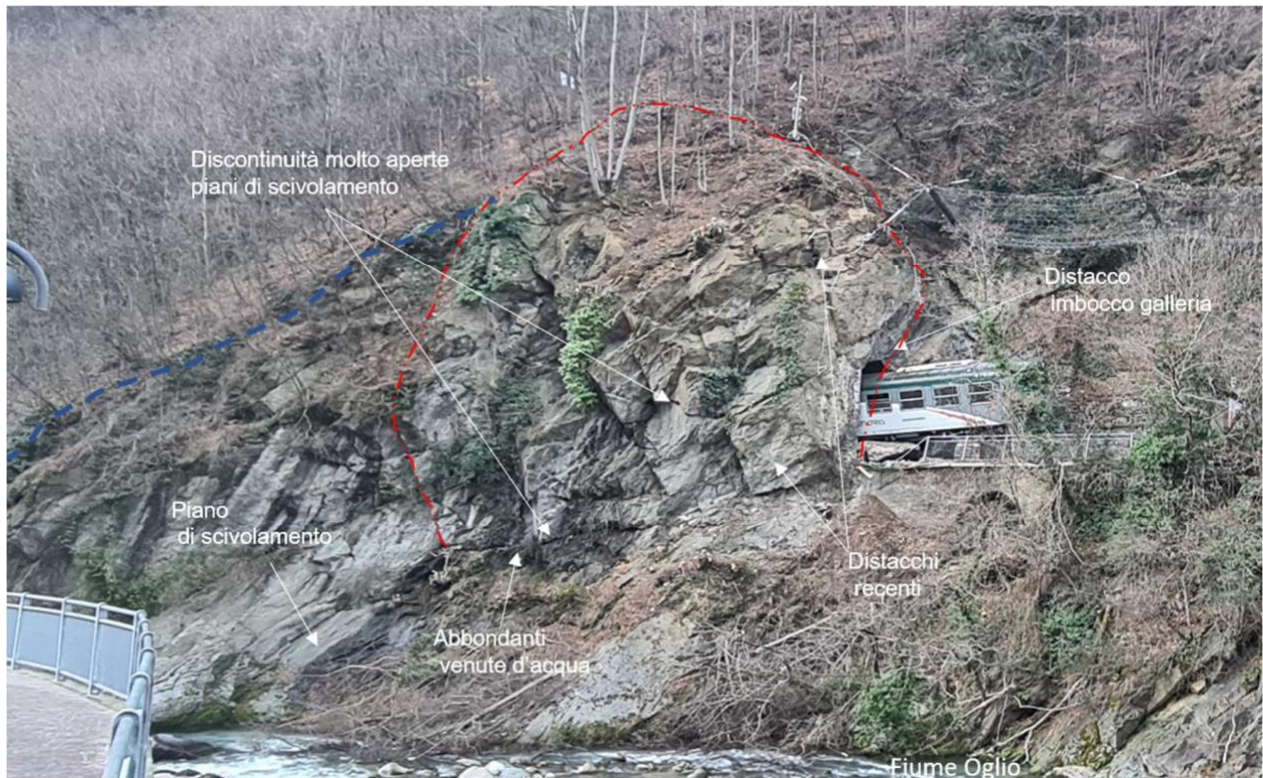
Figura 10 - Panoramica dell'area instabile segnata in tratto rosso, in tratto blu la nicchia di distacco antica segno della passata azione erosiva del fiume Oglio; (Fonte: NOTA TECNICA RELATIVA ALLA POTENZIALE INSTABILITA' DEL VERSANTE IN SPONDA DESTRA OROGRAFICA AL FIUME OGLIO IN COMUNE DI SELLERO (BS) IN CORRISPONDENZA DEL TRATTO DI GALLERIA NATURALE SELLERO 4-5 ED IL SUO IMBOCCO NORD – 31-01-2022).
