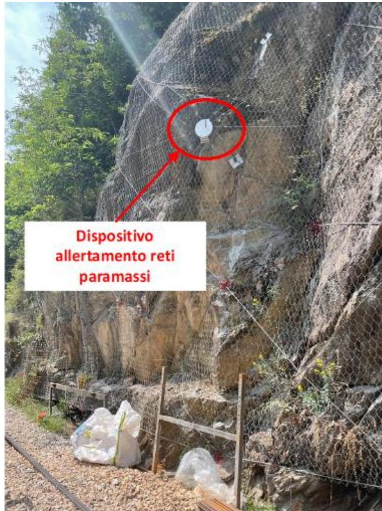
Figura 13 – Localizzazione del dispositivo di allertamento reti paramassi sul versante (fonte: Commissione d'indagine - sopralluogo del 01/06/2022).
