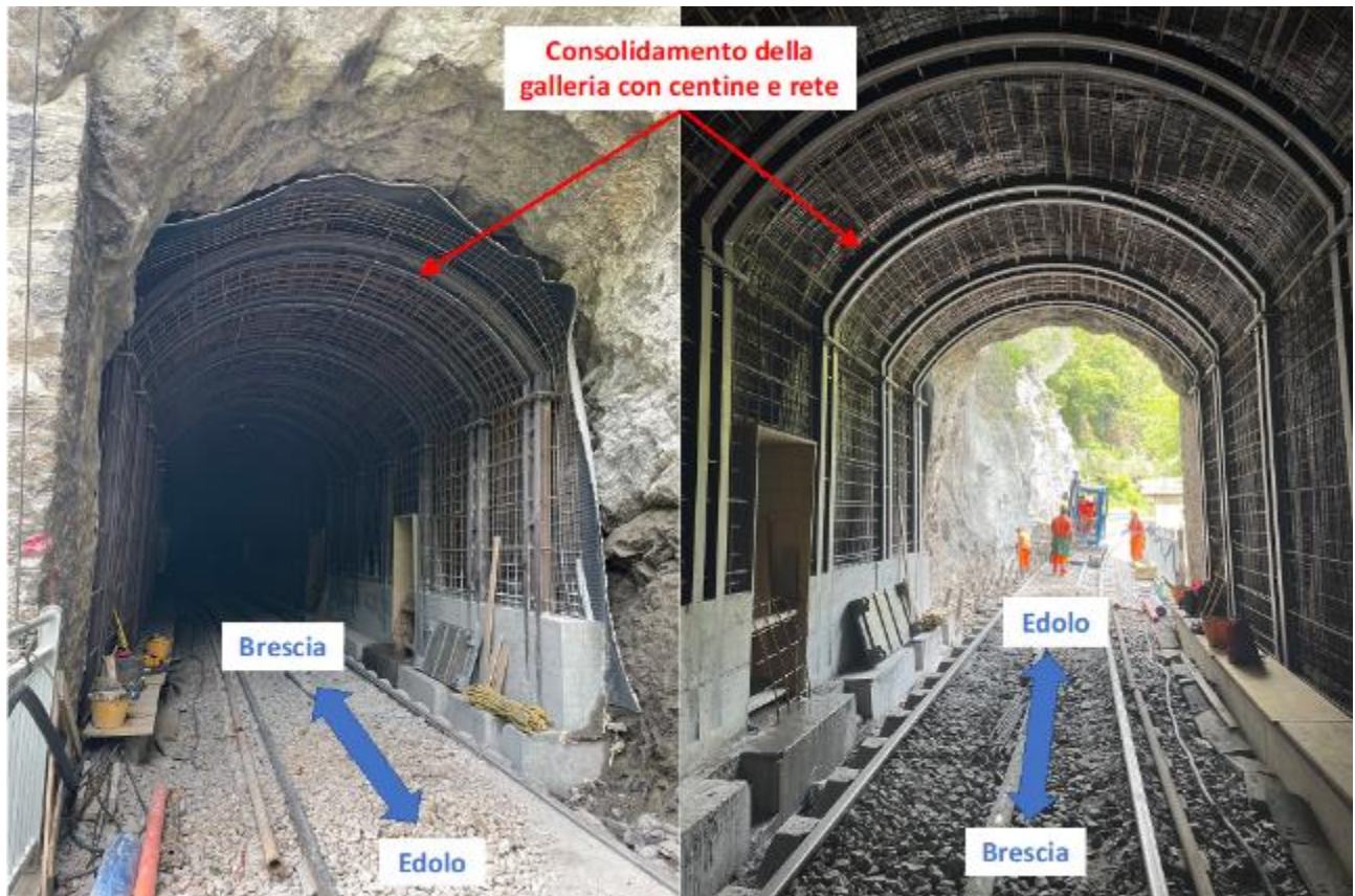
Figura 16 – Attività di consolidamento della galleria con centine e rete (fonte: Commissione d'indagine - sopralluogo del 01/06/2022).
