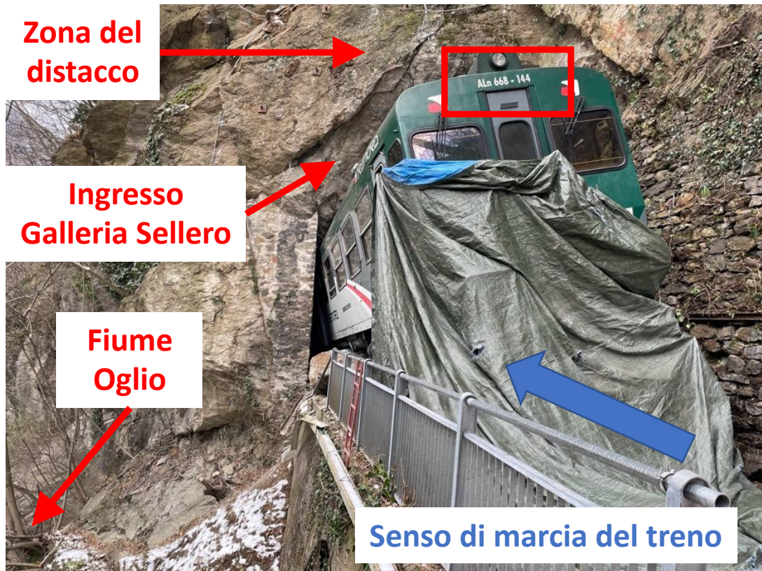
Figura 3 – Prima vettura del treno; retro dell'Automotrice ALn 668 -144 dopo lo scavalco del masso e lo svio. In basso a sinistra corre il fiume Oglio mentre si osserva nella parte alta dell'ingresso galleria la zona del distacco del masso (fonte: Commissione d'indagine - sopralluogo del 10/12/2021).
