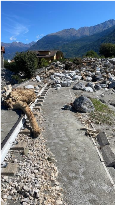
Figura 11 – Danni all'infrastruttura ferroviaria causati dall'alluvione (fonte: https://www.gazzettadellevalli.it/valle-camonica/edolo/alluvione-a-niardo-e-braone-800-mila-euro-dalla-regione-383190/ e TRENORD).
