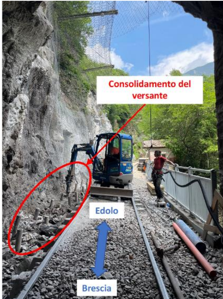
Figura 15 – Attività di consolidamento del versante per la realizzazione della galleria paramassi (fonte: Commissione d'indagine - sopralluogo del 01/06/2022).
