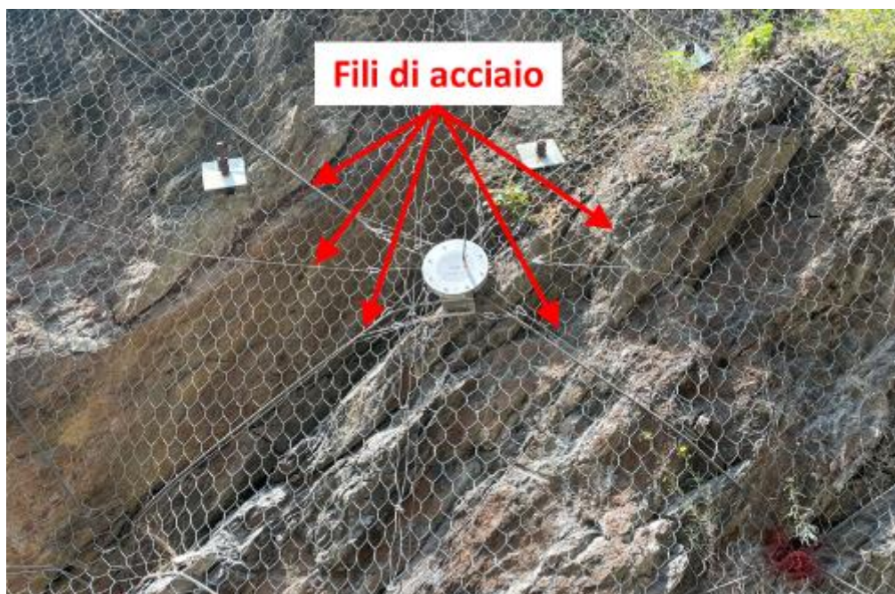
Figura 14 – Dettaglio del dispositivo di allertamento reti paramassi e dei fili di acciaio che rilevano la tensione della rete (fonte: Commissione d'indagine - sopralluogo del 01/06/2022).
