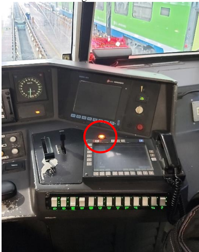
Rif. 2: pulsante luminoso sul Banco di Manovra Principale (fonte: DiGIFeMa)
