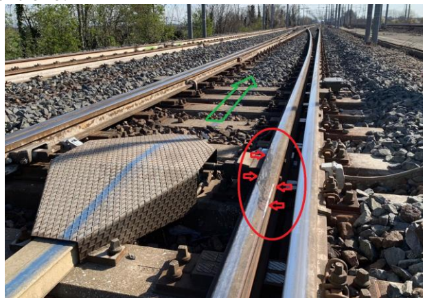
25. Abrasione ago dx deviatoio n. 6 (fonte RFI)
