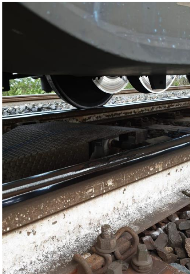
29. Abrasione ago dx deviatoio n. 6 (fonte RFI)
