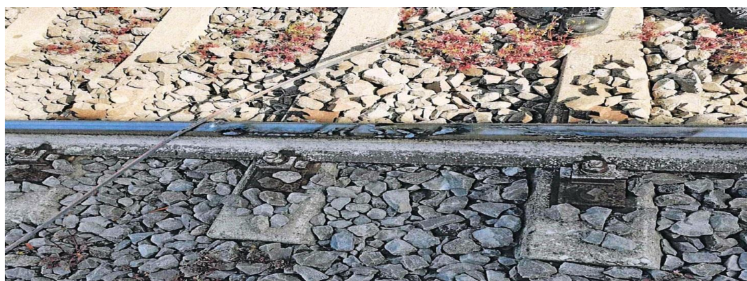
Foto n. 05- Binario danneggiato dall'evento del 02.04.2021 – (Fonte Relazione ATAC)
