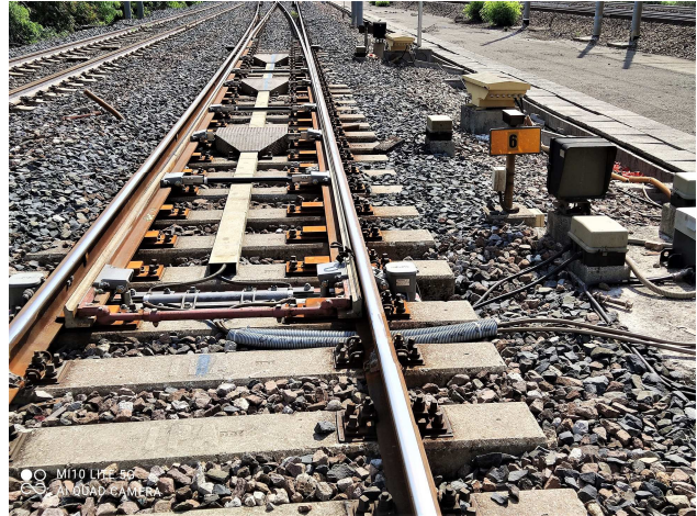
Deviatoio n.6 disposto per la deviato
