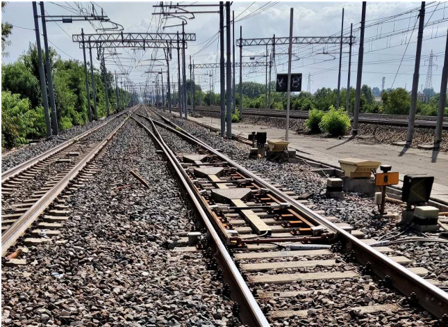
Linea Treviglio Ovest - Bergamo. Deviatoio n.6
