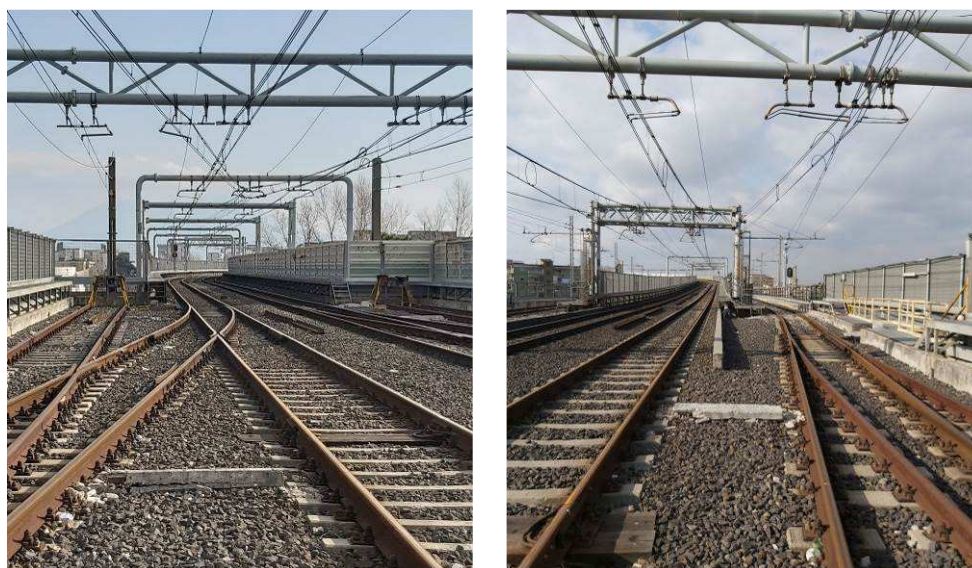
Figura 12 - Vista direzione Piscinola dell'infrastruttura ferroviaria sede dell'incidente, a sinistra, e direzione Chiaiano, a destra (fonte: DIGIFEMA, accesso alla linea del 24/01/2020)
