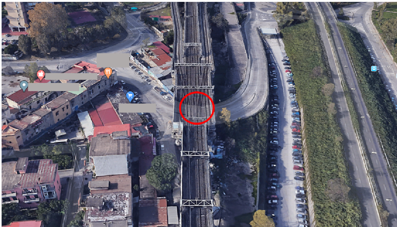
Figura 8 - Foto aerea della Linea 1 della Metropolitana di Napoli con evidenziata la zona del deviatoio di innesto dalla rampa dispari di immissione in linea dal Deposito di Piscinola (fonte: Google Maps)
