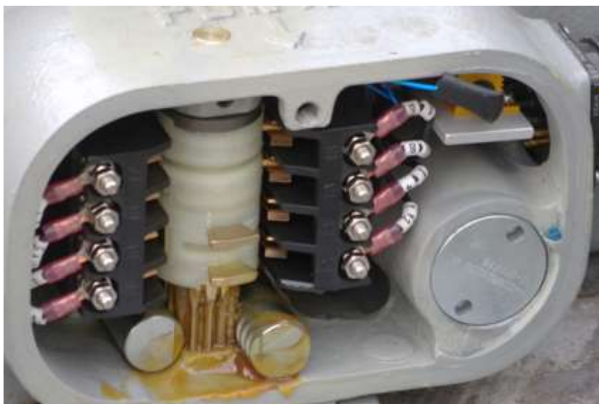
Figura 3 – Cassetta dell'attuatore n. 2 del telaio di punta del deviatoio n. 5 dopo l'incidente (fonte: Digifema)
