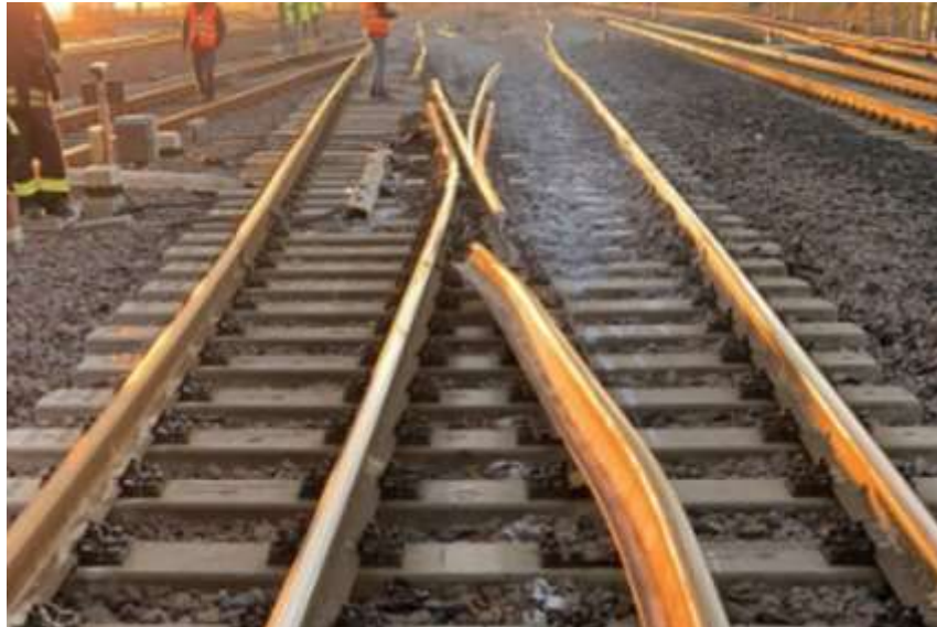
Figura 2 – Punto iniziale dello svio, deviatoio n. 5, km 166+756 (fonte: web)
