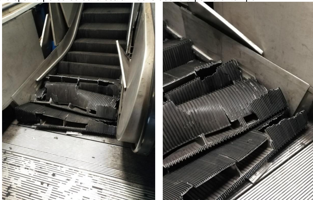
Figure 5 e 6 - Gradini scala mobile matr.54NF6339 a seguito dell'evento (fonte Digifema)
