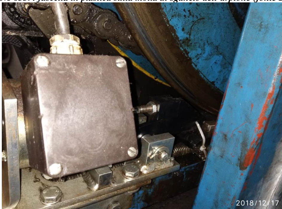
Figura 72 – Componente orizzontale del freno d'emergenza della scala mobile matr. 54NF6339: fascetta in plastica sul cane di sgancio del cuneo (fonte Digifema)
