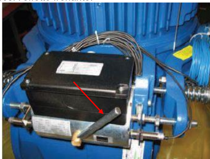
Figura 54 – Leva di apertura manuale del freno di servizio (fonte Manuali altra azienda costruttrice)
