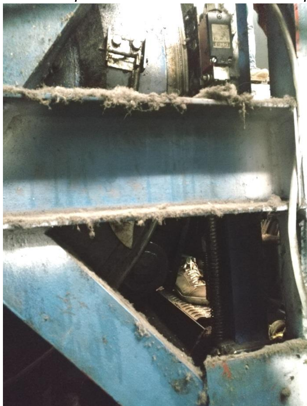
Figure 73 e 74 – Componente verticale del freno d'emergenza della scala mobile, matricola 54NF6339: dettaglio del fine corsa non impegnato dal cuneo (fonte Digifema)
