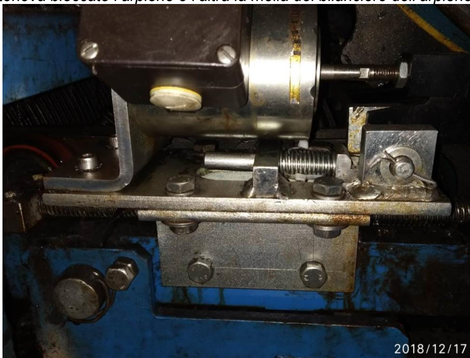
Figura 71 – Componente orizzontale del freno d'emergenza della scala mobile matr. 54NF6339: fascetta in plastica sulla molla di sgancio dell'arpione (fonte Digifema)
