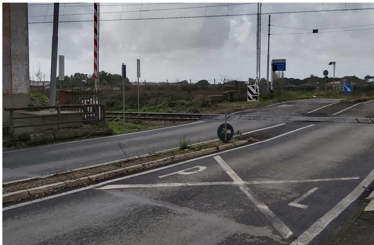
Figura 24 - Segnaletica orizzontale di avviso di presenza di PL ferroviario sulla SP127 in direzione Ciampino (fonte Digifema)
