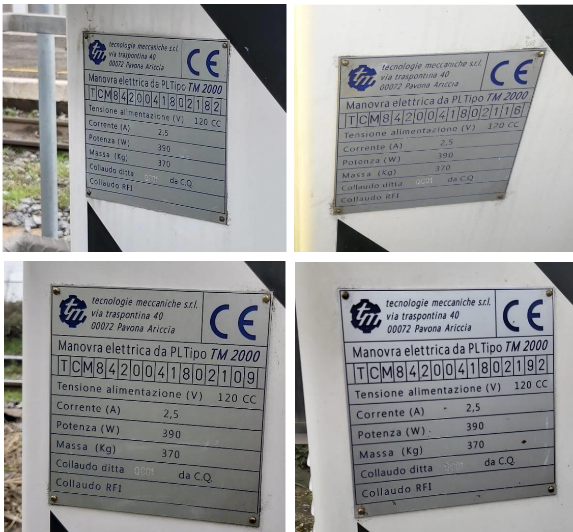
Figure 8 - Dati di Targa delle casse di manovra delle barriere PL km 15+977 (fonte Digifema)
