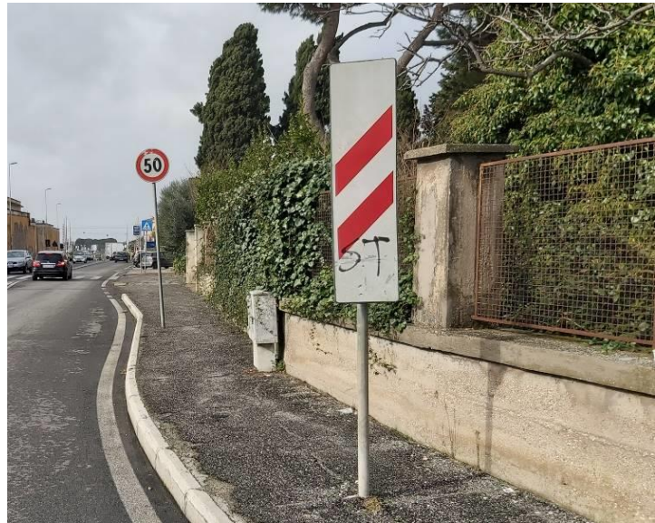
Figure 20 - Pannelli distanziometrici 11/a e 11/b sulla SP127 in direzione Ciampino (fonte Digifema)
