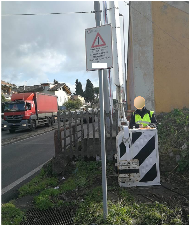
Figura 11 - Segnaletica di Avviso di Rete Ferroviaria Italiana, recante in evidenza il numero di telefono da contattare in caso di emergenza - Direzione Velletri (fonte Digifema)
