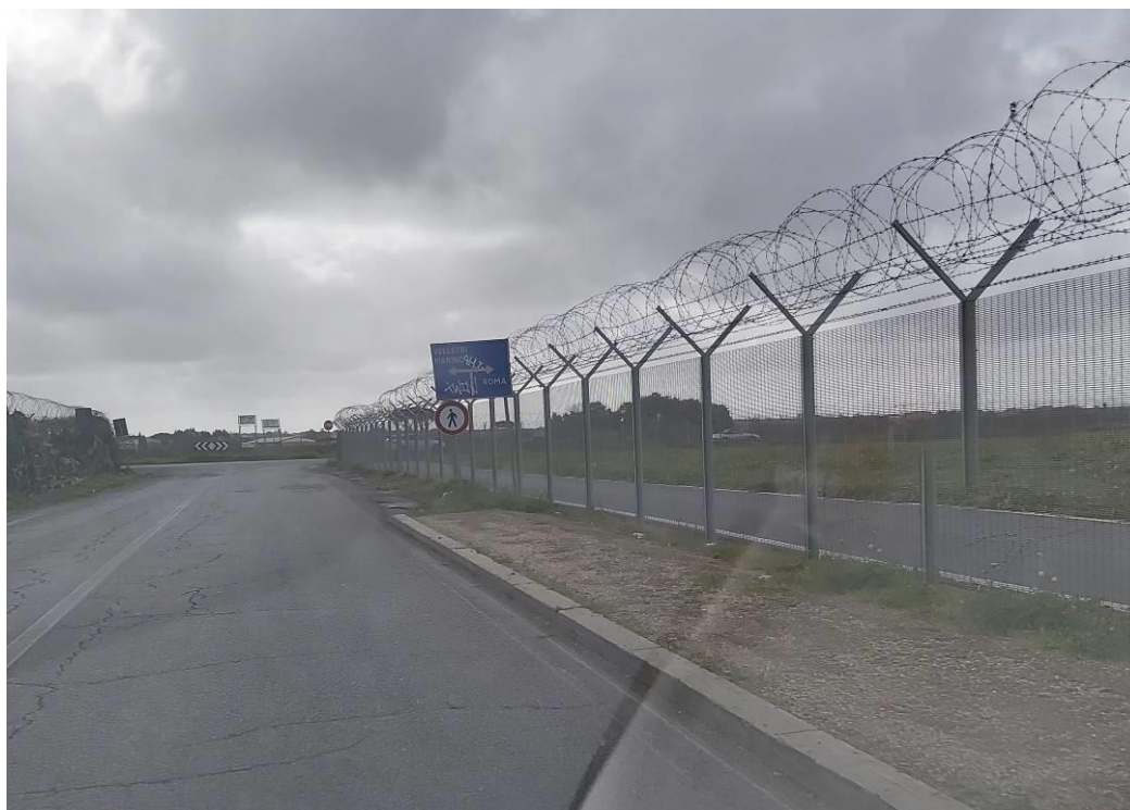
Figura 9 - Vista della direttrice (viale di Marino) parallela alla linea ferroviaria in appoggio al PL km 15+977 (fonte Digifema)
