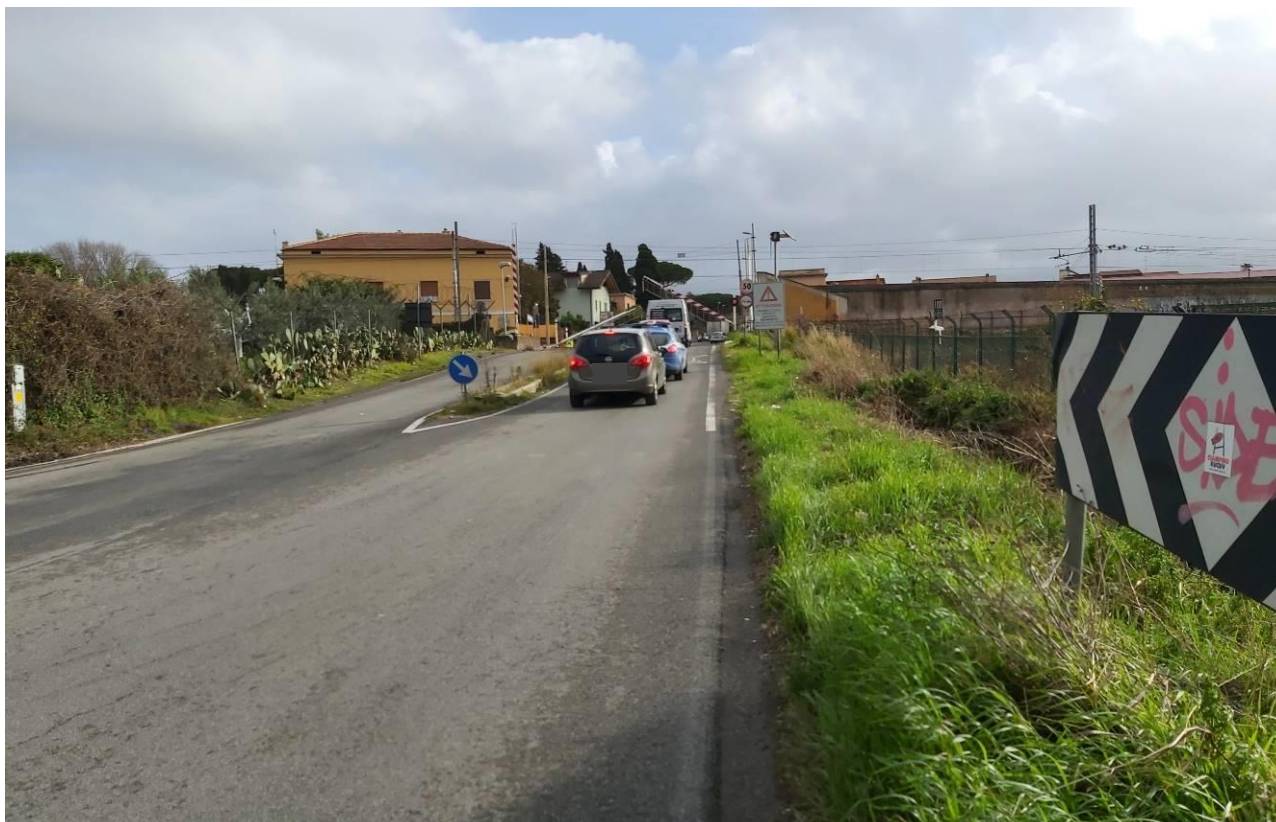
Figura 23 - SP127 via dei Laghi in corrispondenza del punto d'innesto con viale di Marino (fonte Digifema)
