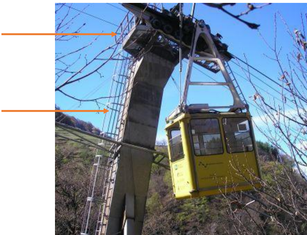
Foto n. 05 – Sostegno di linea con evidenza della scala a gabbia e pedana d'arrivo (fonte archivio successiva a revisione generale 2011)
