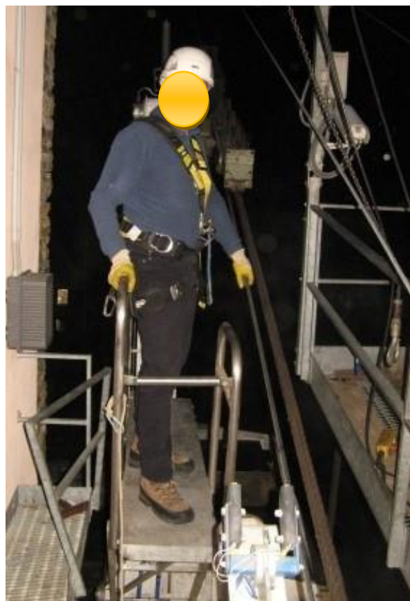
Foto n. 04 - Stazione di valle: compatibilità installazione piattaforma mobile di ispezione con franchi pedana fissa n.1 danneggiata a seguito dell'evento (fonte Relazione inchiesta evento art. 93 DPR 753/1980)
