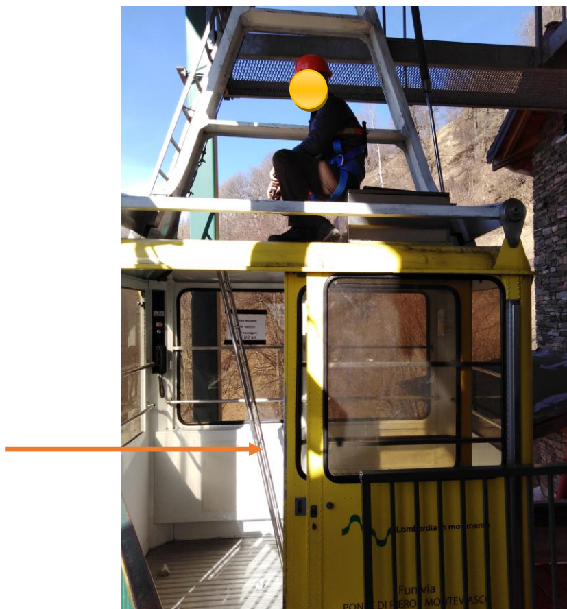
Foto n. 10 – Cabina: scaletta interna da cabina a tetto (fonte sopralluogo Digifema del 28/02/2019)
