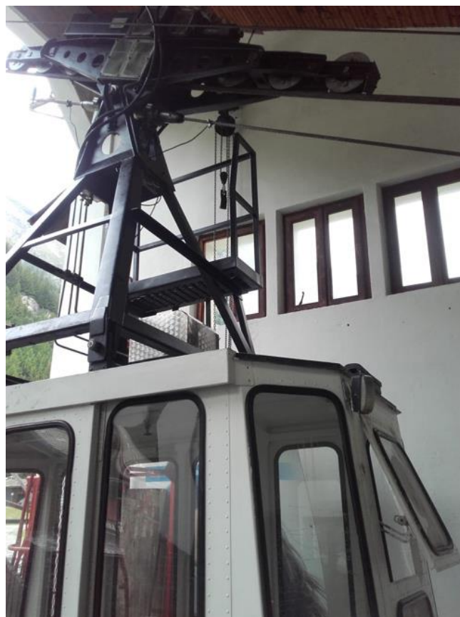
Foto n. 21b - Funivia Macugnaga - Alpe Bill (Piemonte), Ceretti 1962, (15 posti), rev.1981-2002, 2 cabine, campata unica ( fonte USTIF Piemonte )
