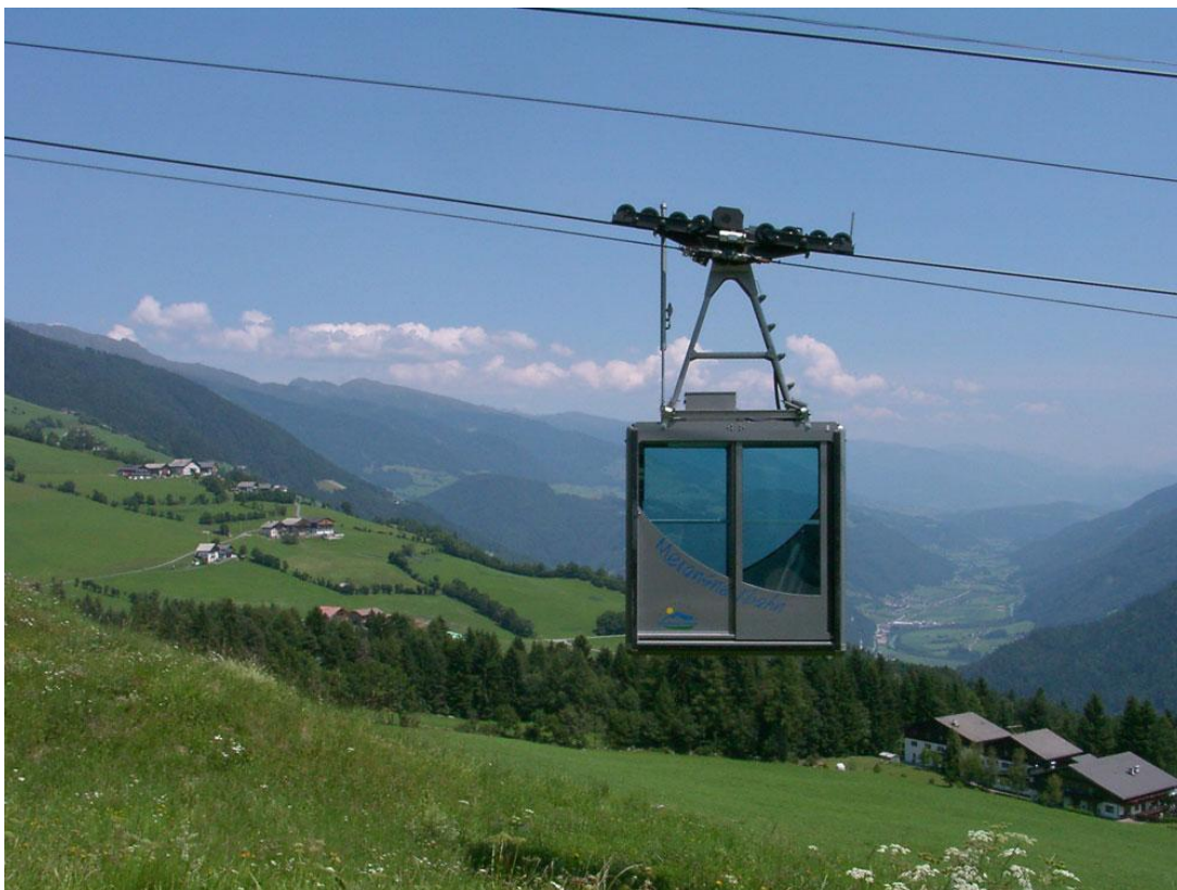
Foto n. 15 – Funivia Rio Pusteria - Maranza (Bolzano), Hölzl 1957, (12 posti), 2 cabine, 5 sostegni ( fonte Provincia Autonoma di Bolzano )
