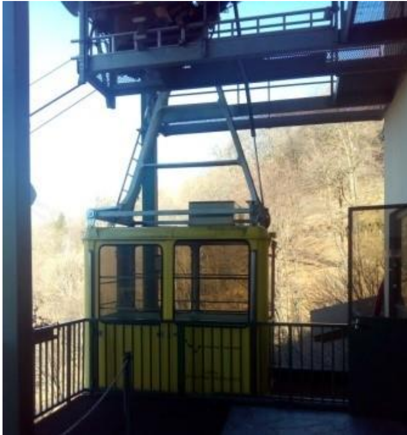
Foto n. 07 – Stazione di monte con cabina in fossa (fonte Relazione inchiesta evento art. 93 DPR 753/1980 )
