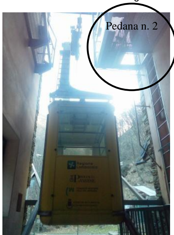
Foto n. 02 – Stazione di valle, cabina in entrata: pedana fissa di manutenzione n. 2 (fonte Relazione inchiesta evento art. 93 DPR 753/1980 )
