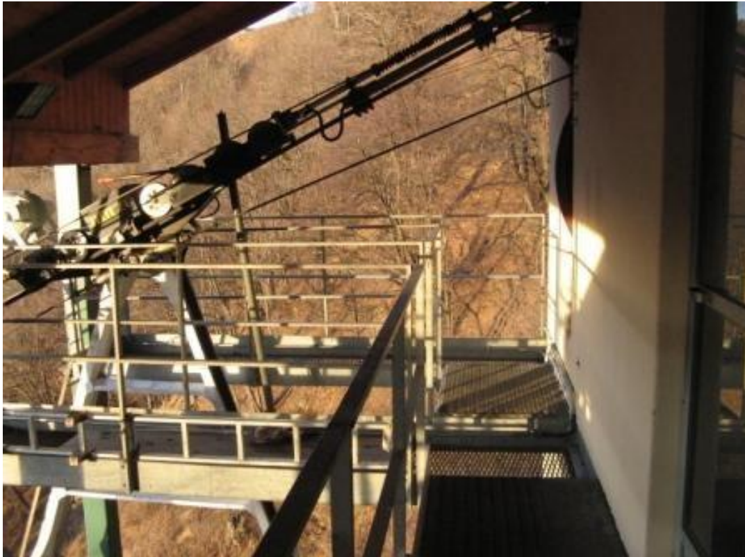
Foto n. 08 – Stazione di monte: pedane di manutenzione con accesso da scala fissa, vista d'insieme (fonte Relazione inchiesta evento art. 93 DPR 753/1980 )
