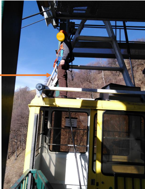
Foto n. 11 - Operatore in piedi sul tetto della cabina da cui poter accedere sulla scala montata sul braccio di sospensione lato valle (fonte sopralluogo Digifema del 28/02/2019)
