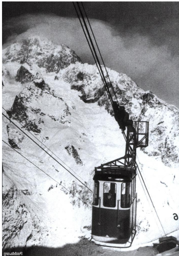
Foto n. 20b - Funivia Cresta di Youla - Cresta d'Arp (Valle D'Aosta) Ceretti 1963, (8 posti), 2 cabine, campata unica ( foto storica, fonte internet )
