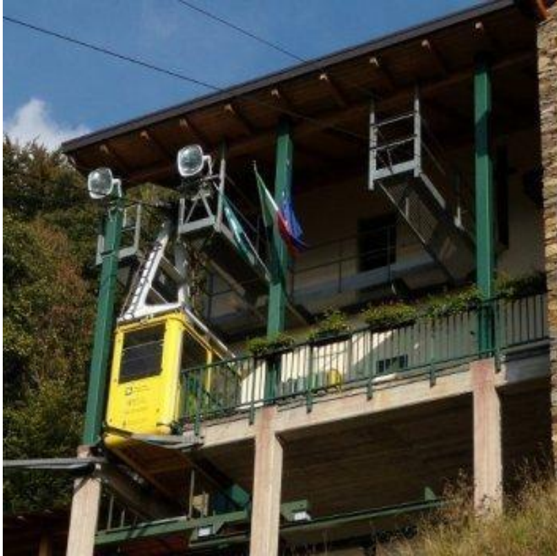
Foto n. 06 – Stazione di monte con cabina in fossa (fonte archivio successiva a revisione generale 2011 )
