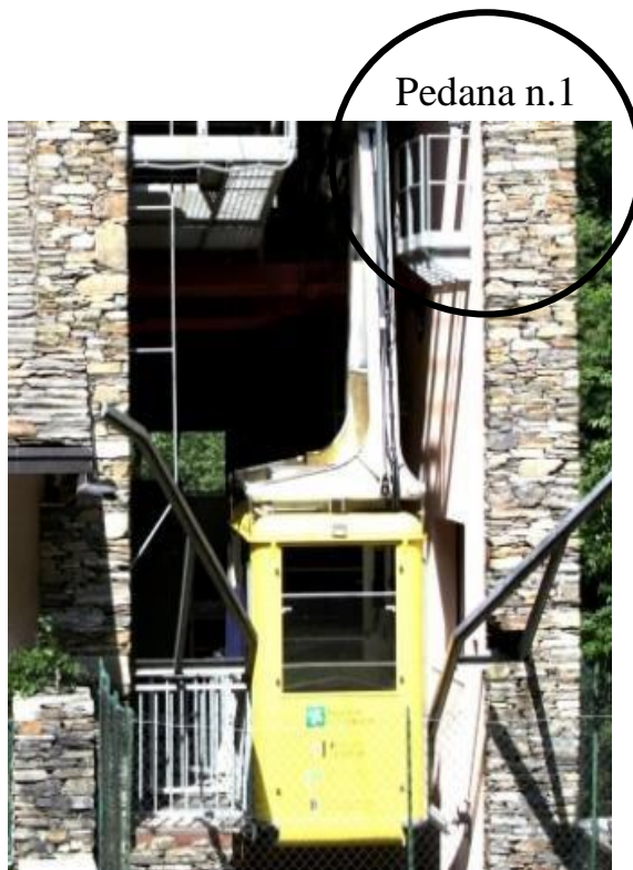
Foto n. 01 – Stazione di valle, cabina ferma: pedana fissa di manutenzione n. 1 (fonte archivio antecedente revisione generale 2011 )
