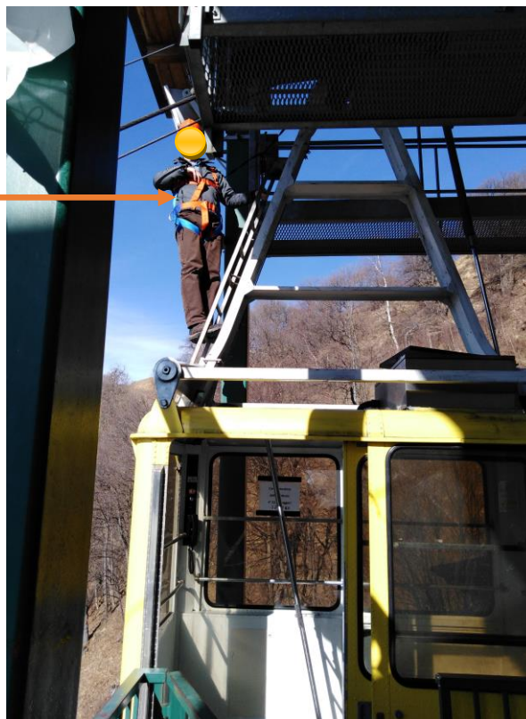
Foto n. 12 - Operatore posizionato sul secondo gradino della scala esterna montata sul braccio della sospensione, per sblocco freno emergenza, assicurato con cintura al maniglione (fonte sopralluogo Digifema del 28/02/2019)
